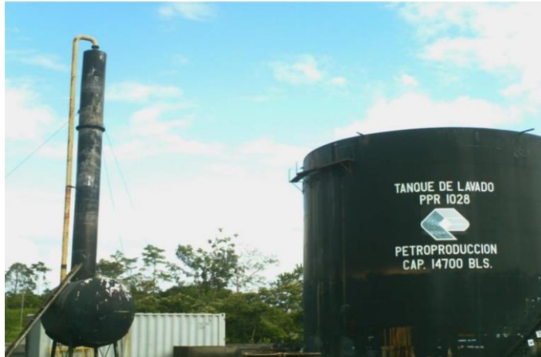
Figura 2. 4. Bota de gas y tanque de lavado de estación LAC Fuente: (Ramirez, 2009)
