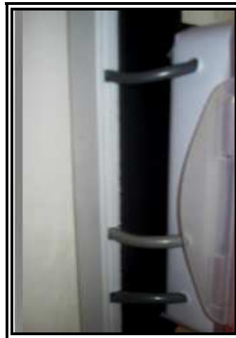
Figura 3.16 Cables que ingresan al panel de control.
