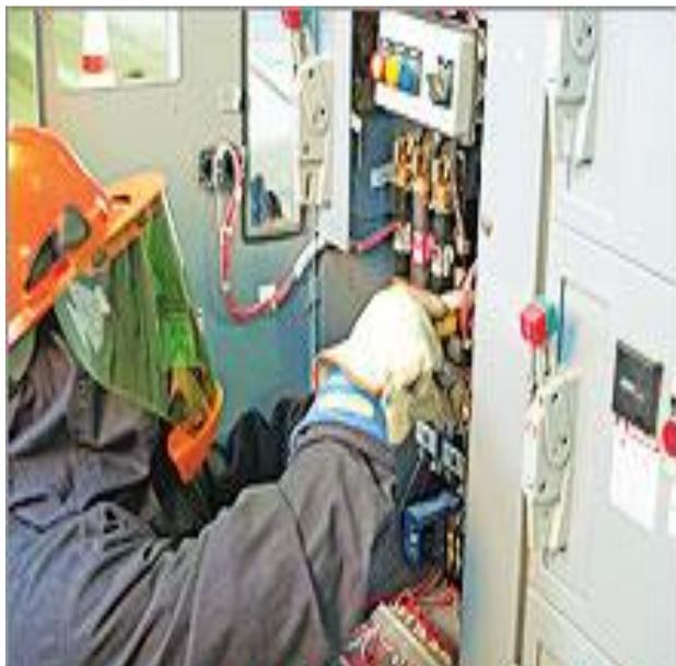
**Figura 3:** Revisión de tablero con protección personal
