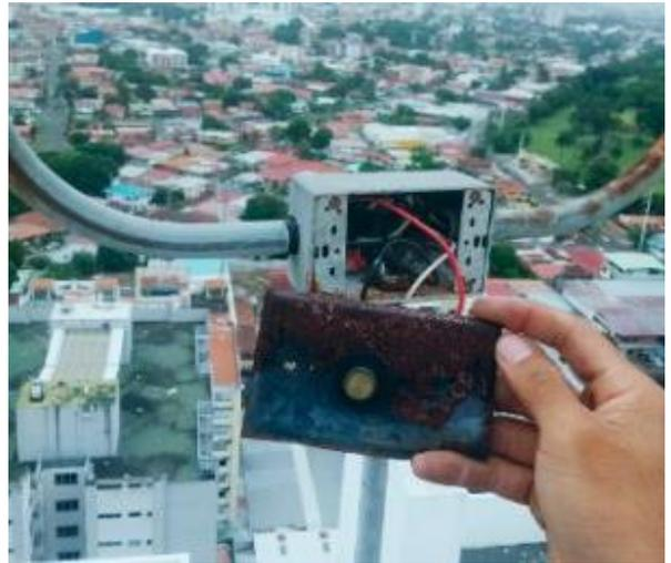
**Figura 1:** Revisión de estado de caja eléctrica de paso
