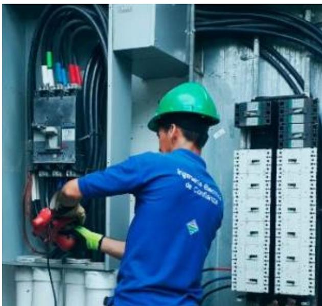
**Figura 2:** Inspección de un tablero de control
