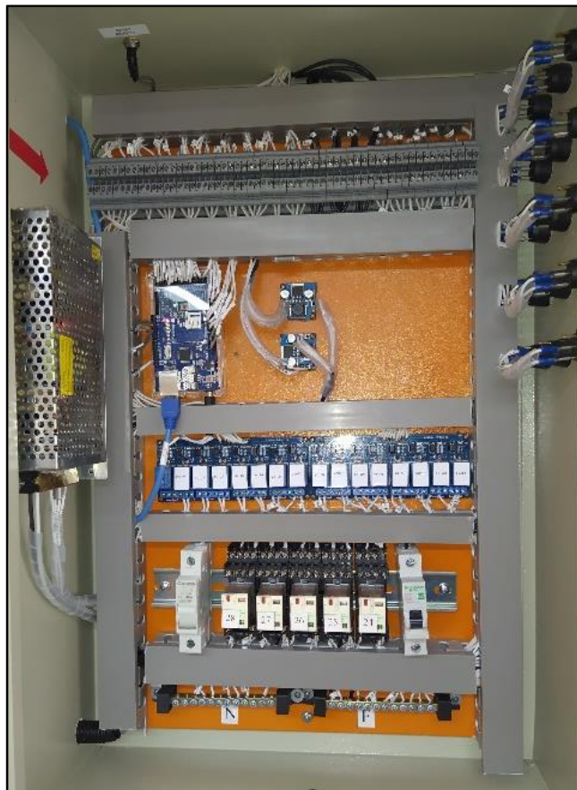
Figura 3.26: Implementación del tablero finalizada. (Fuente Propia)
