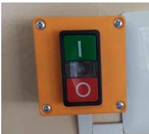
Figura 3.26 Pulsadores para el control de las luces de cada aula (Fuente Propia)
