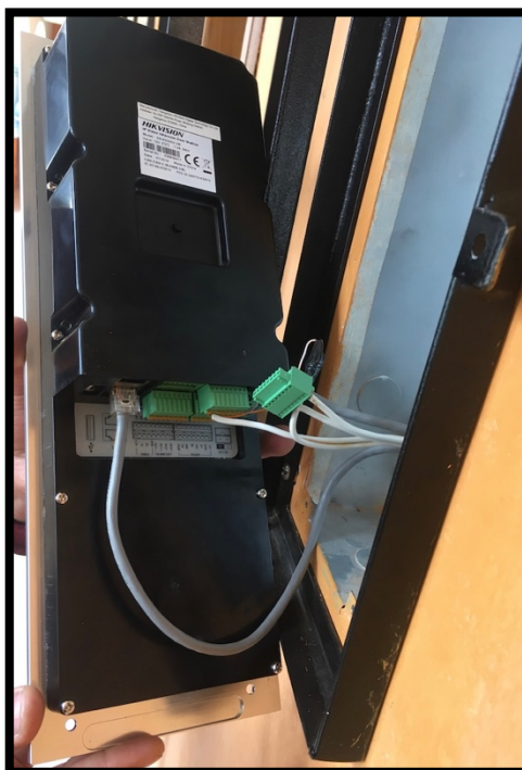
Figura 3.21: Conexión de chapa eléctrica.
