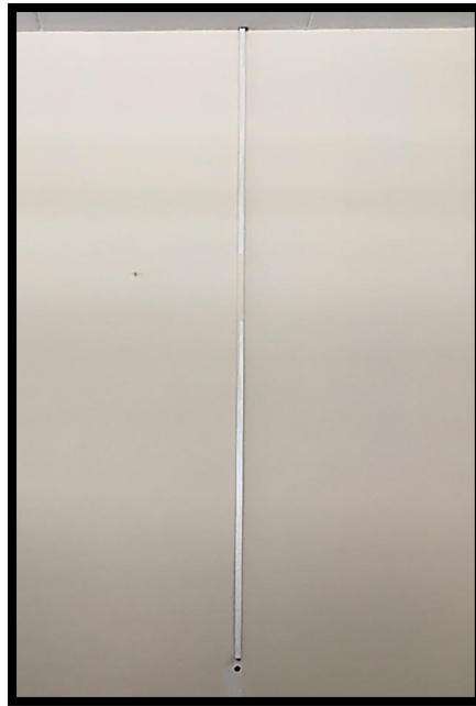
Figura 3.7: Anclaje de canaletas en oficinas de la zona D.
