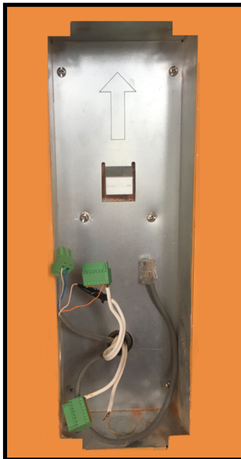
Figura 3.18: Anclaje caja de protección a la pared.
