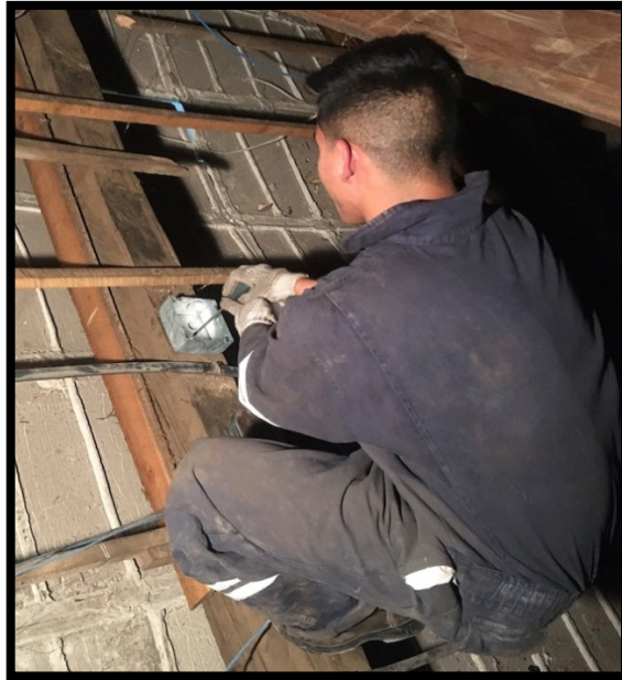
Figura 3.3: Anclaje de cajas de paso y revisión.
