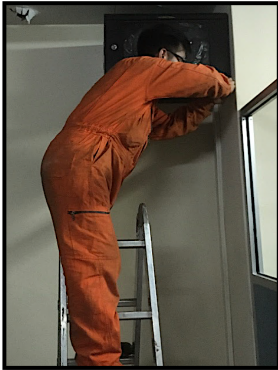
Figura 3.9: Ubicación del gabinete en la zona D.
