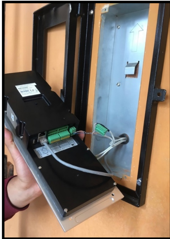
Figura 3.19: Alimentación y conexión de placa exterior.
