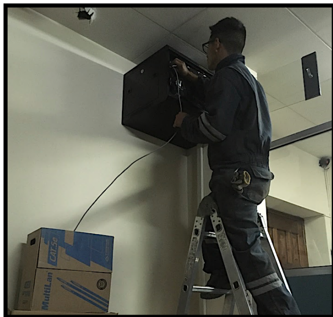
Figura 3.10: Ruteo de cable UTP en la zona D.
