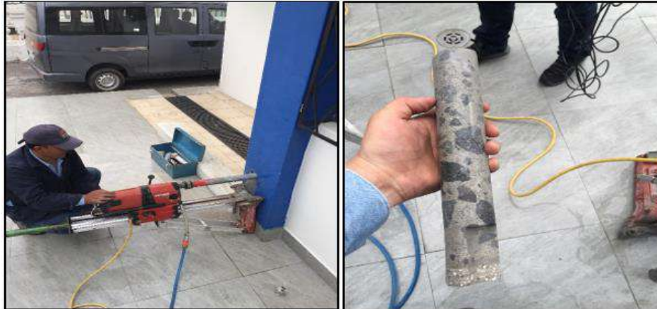
Figura 2. 5 Extracción de núcleos.
