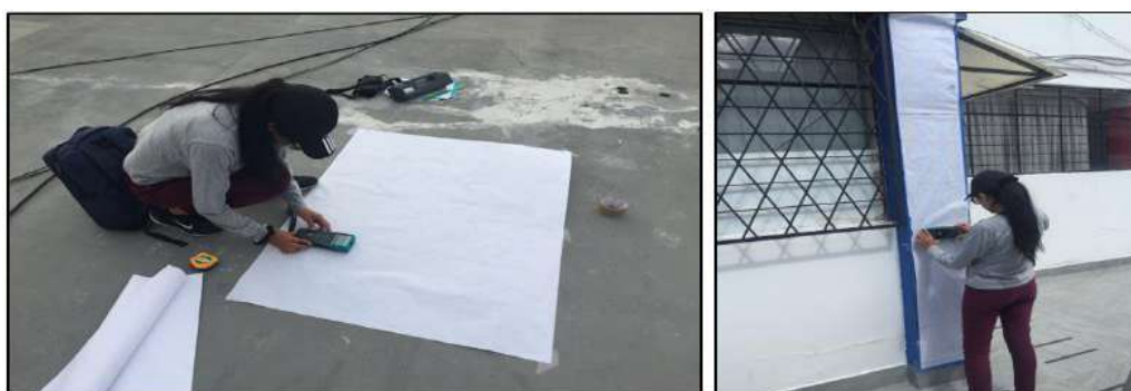
Figura 2. 10 Ensayo medidor de cobertura y detección de acero (Pachómetro). Fuente: Chávez y Gómez.
