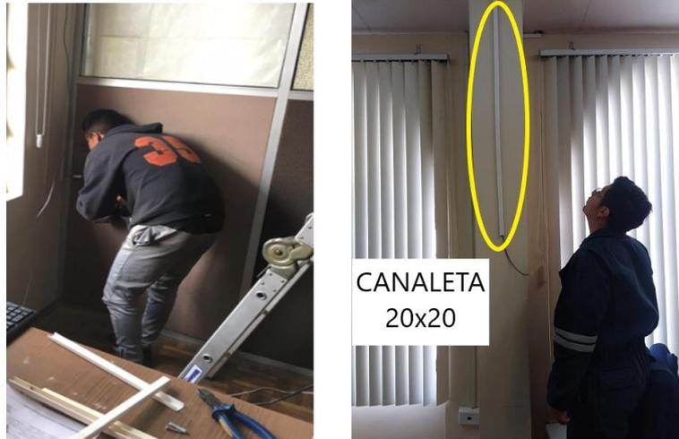
**Figura 3.5.** Montaje de canaletas
