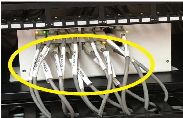
**Figura 3.4.** Etiquetado del cableado estructurado
