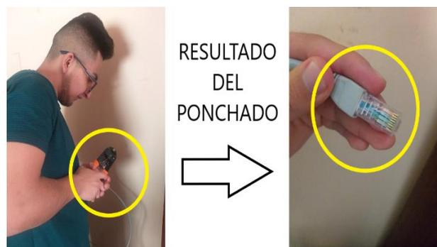
**Figura 3.2.** Pochado del cableado estructurado
