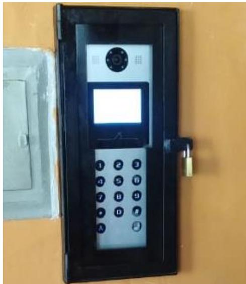
**Figura 3.12.** Protección metálica de la placa
