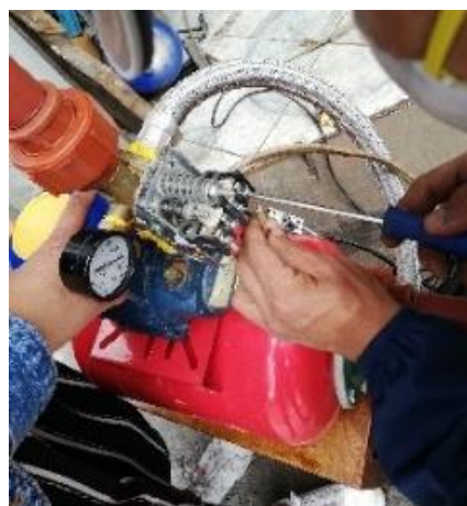
Figura 3.22 Automatización de la bomba
