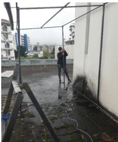
Figura 3.14 Armado y fijación de la estructura metálica
