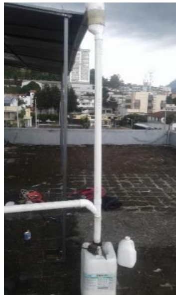
Figura 3.18 Colocación del tanque de primeras aguas
