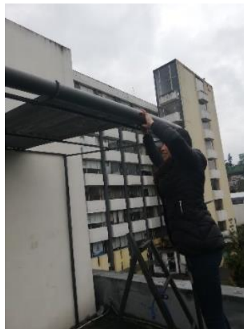
Figura 3.15 Colocación de la techada
