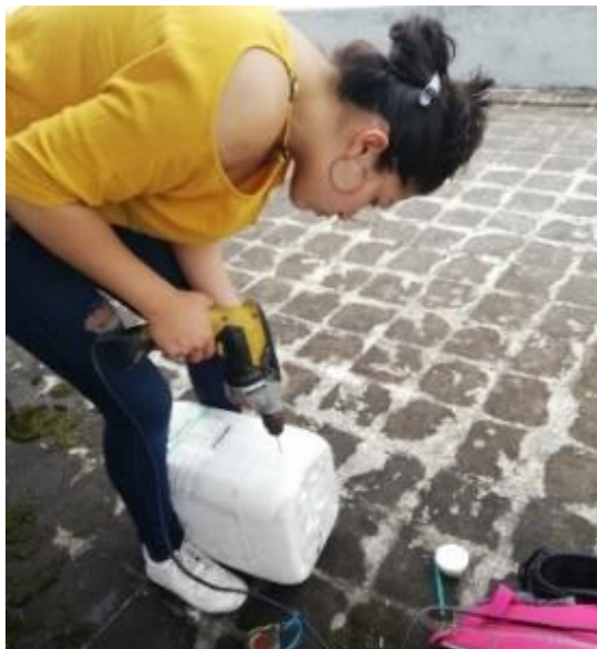
Figura 3.17 Elaboración del agujero en el tanque de primeras aguas
