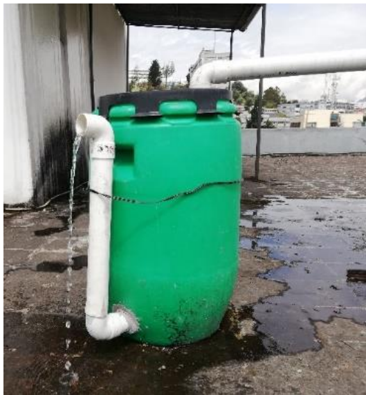
Figura 3.19 Tanque de almacenamiento del prototipo
