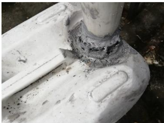
Figura 3.23 Reparación de fugas en el tanque de primeras aguas
