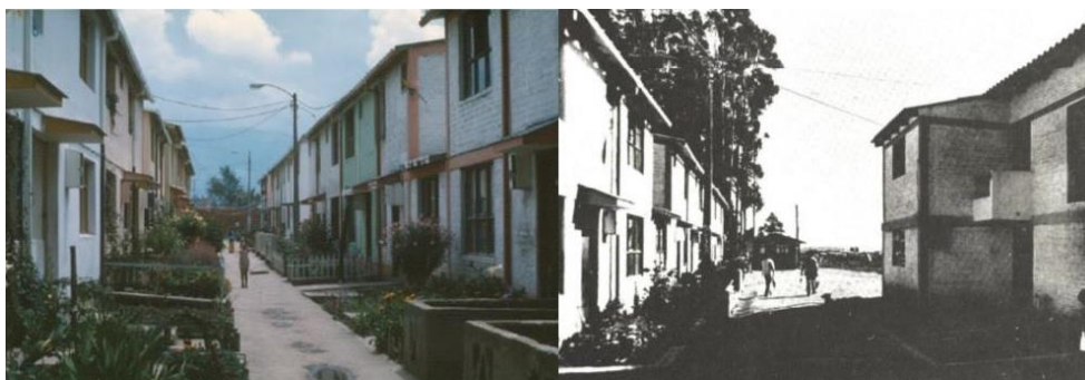
Fotografía 1 Pasajes peatonales originales
