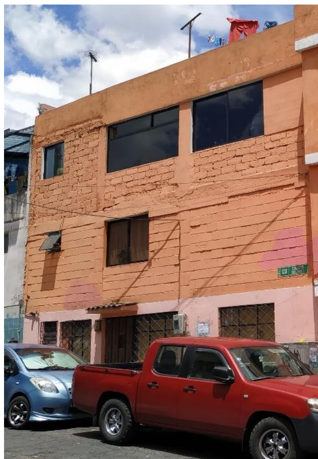
Fotografía 6 Columna corta ELABORADO POR: AGUAIZA
