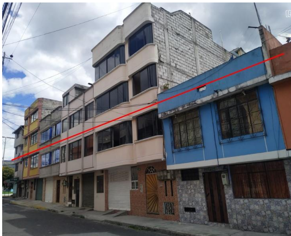
Figura 20 Crecimiento vertical de edificaciones sector Solanda
