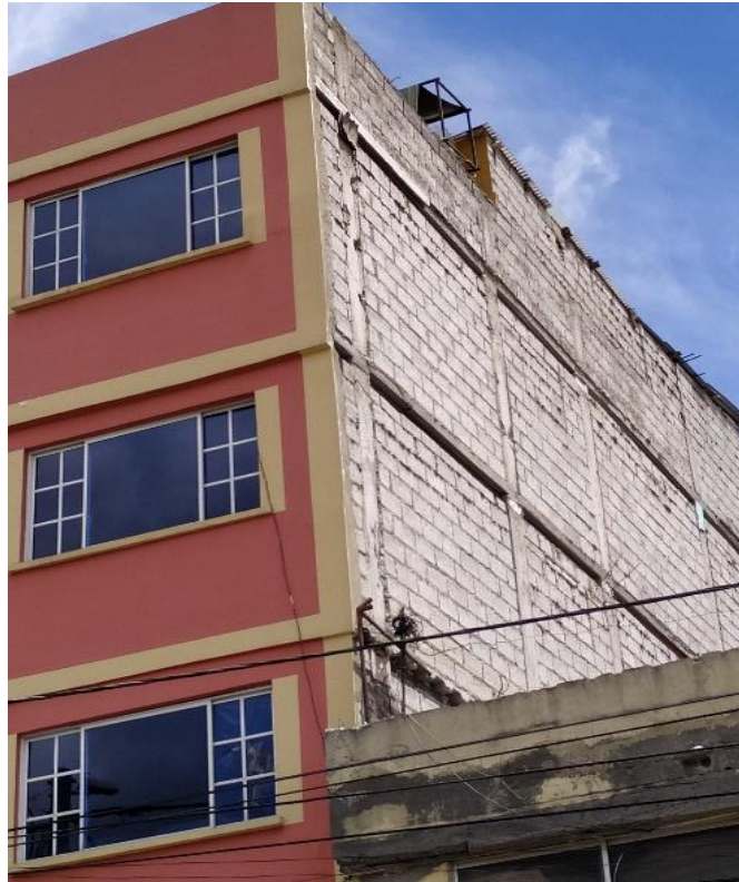
Fotografía 3 Incompatibilidad de materiales ELABORADO POR: AGUAIZA
