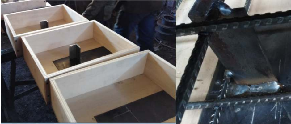
Figura No. 3. 29: Soldadura final de los conectores de corte Elaborado: Jonathan Franco & Miguel Martínez
