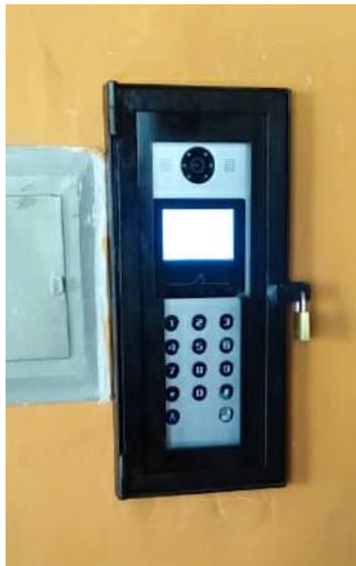
Figura 3.16: Placa externa instalada
