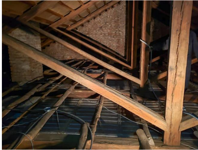
Figura 3.10: Tendido del cableado
