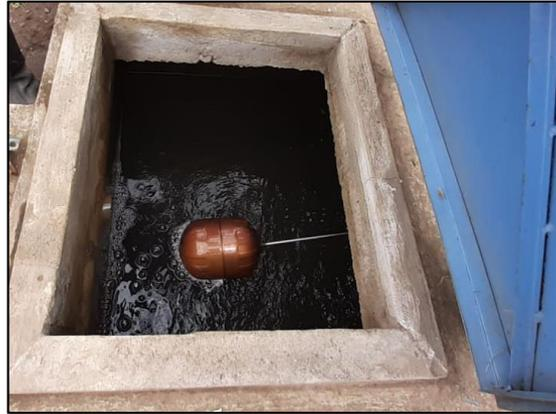
**Figura 28.** Tanque rompe presión.
