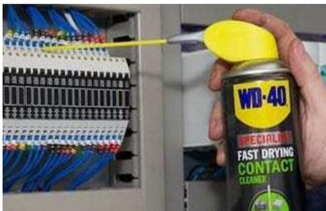
**Figura 53.** Limpia contacto electrónico
