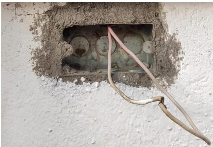
**Figura 3.3.** Empalme en mal estado
