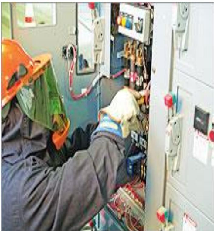
**Figura 22.** Revisión de tablero con protección personal
