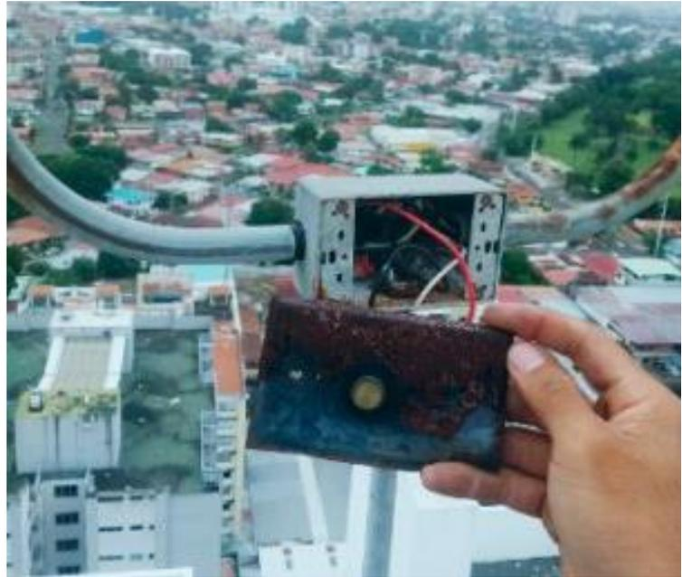
**Figura 20.** Revisión de estado de caja eléctrica de paso
