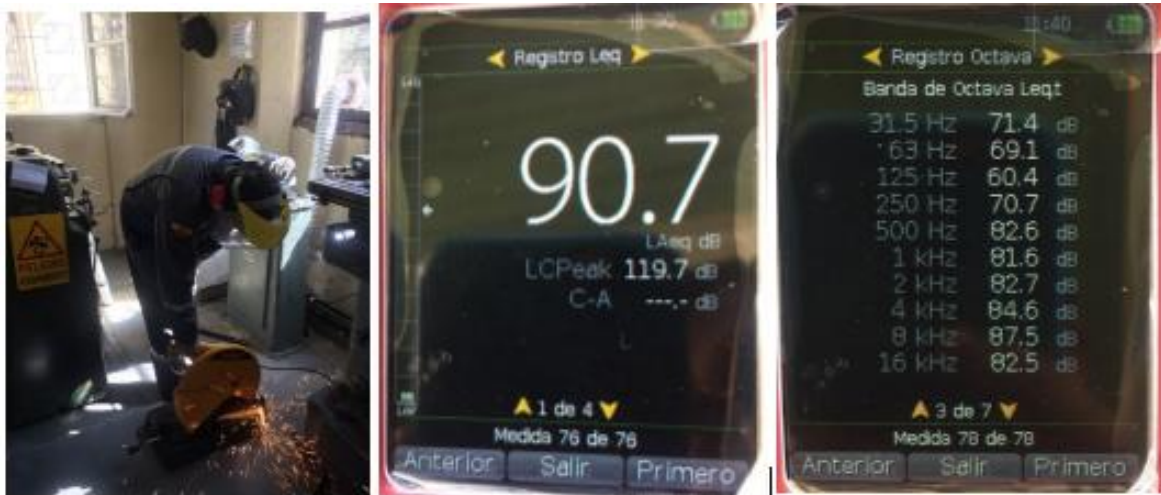
Figura AV.4. Corte de tubos y ángulos metálicos
