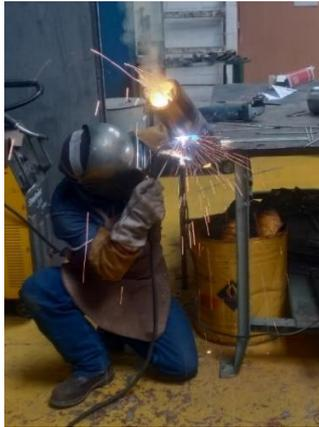
Figura 2.5 Soldadura de la tubería.
