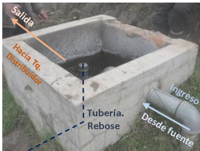
Figura 4.2 Tanque Rompe Presiones
