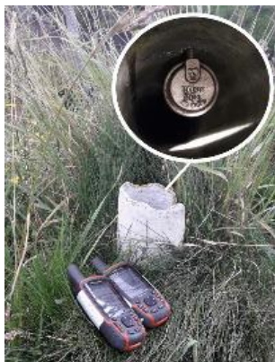
Figura 3.27 Tipo 1 de válvula de aire en la conducción
