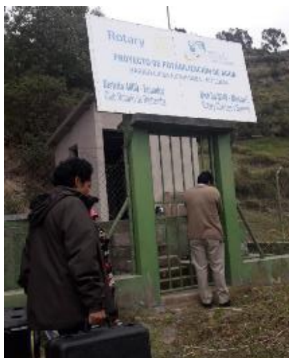
Fotografía 7 Reservorio y planta potabilizadora del barrio Luisa Rumipamba
