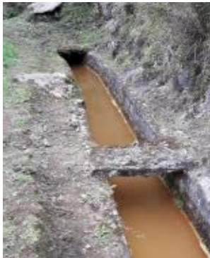
Fotografía 10 Canal de riego que está colindante a la línea de conducción
