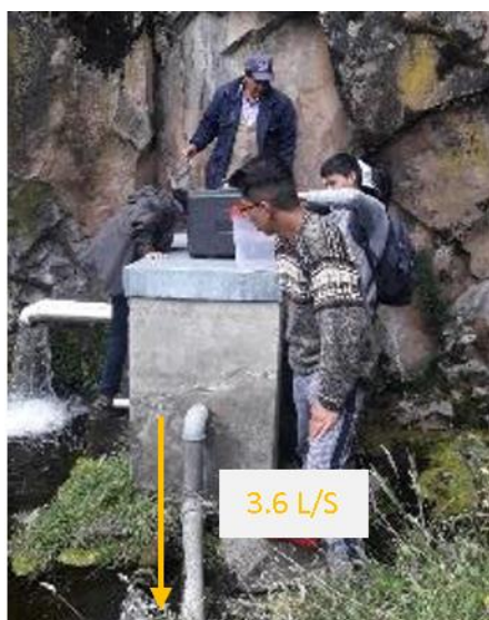
Fotografía 1 Tanque de captación en la Fuente Pailacocha
