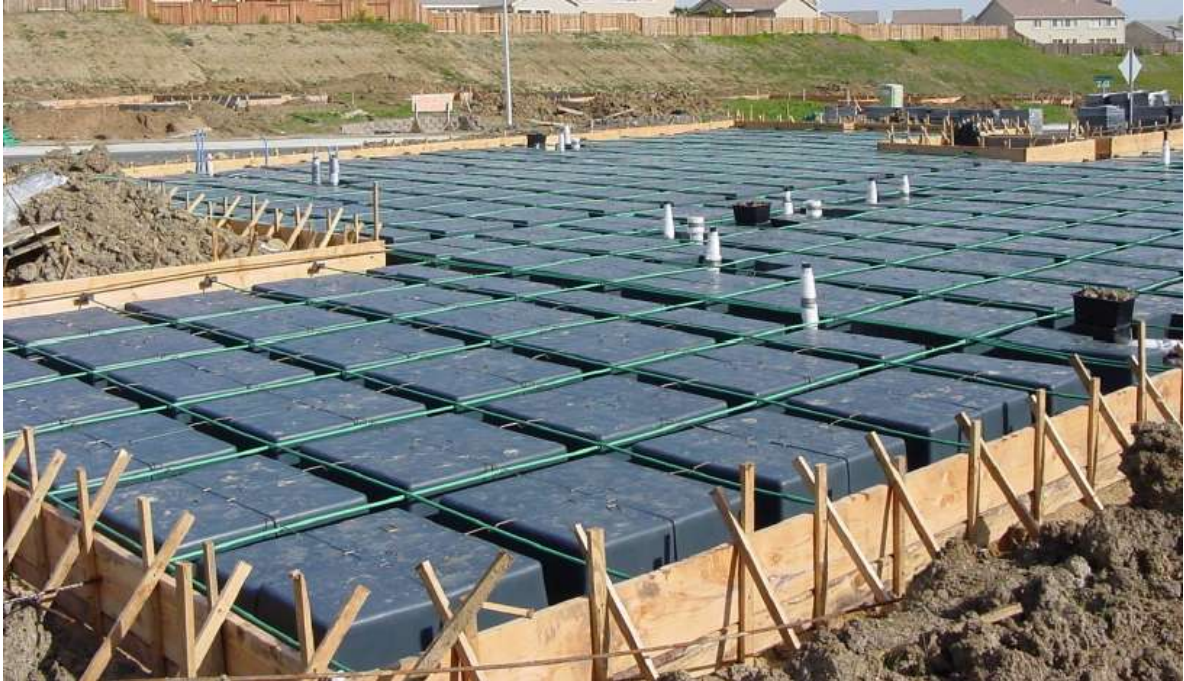
Figura 1.8 Losa de cimentación nervada
