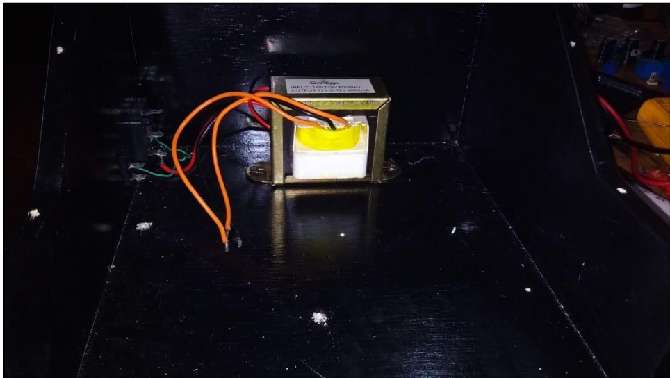
Figura 3.59: Aseguramiento del transformador.
