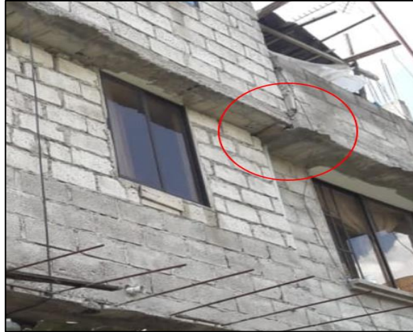
Figura 42. Golpeteo en viviendas. Elaborado por: Castillo, C. & Castillo, J.
