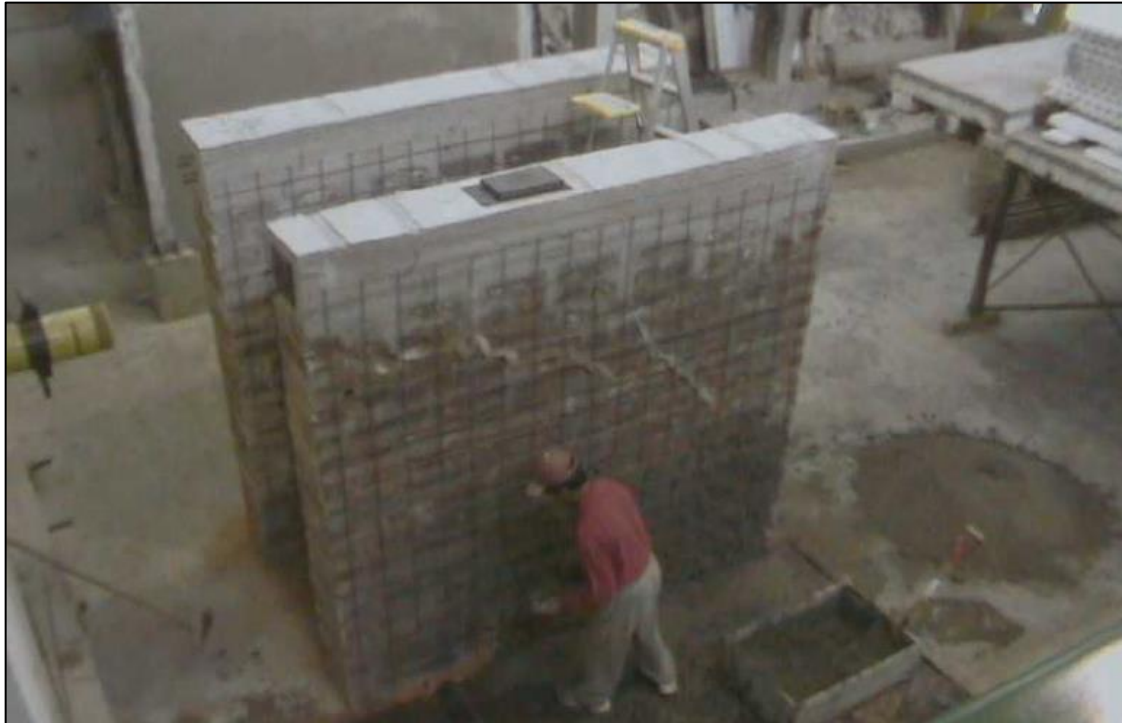
Figura 14. Paredes durante el proceso de colocación del enchape de reforzamiento.
