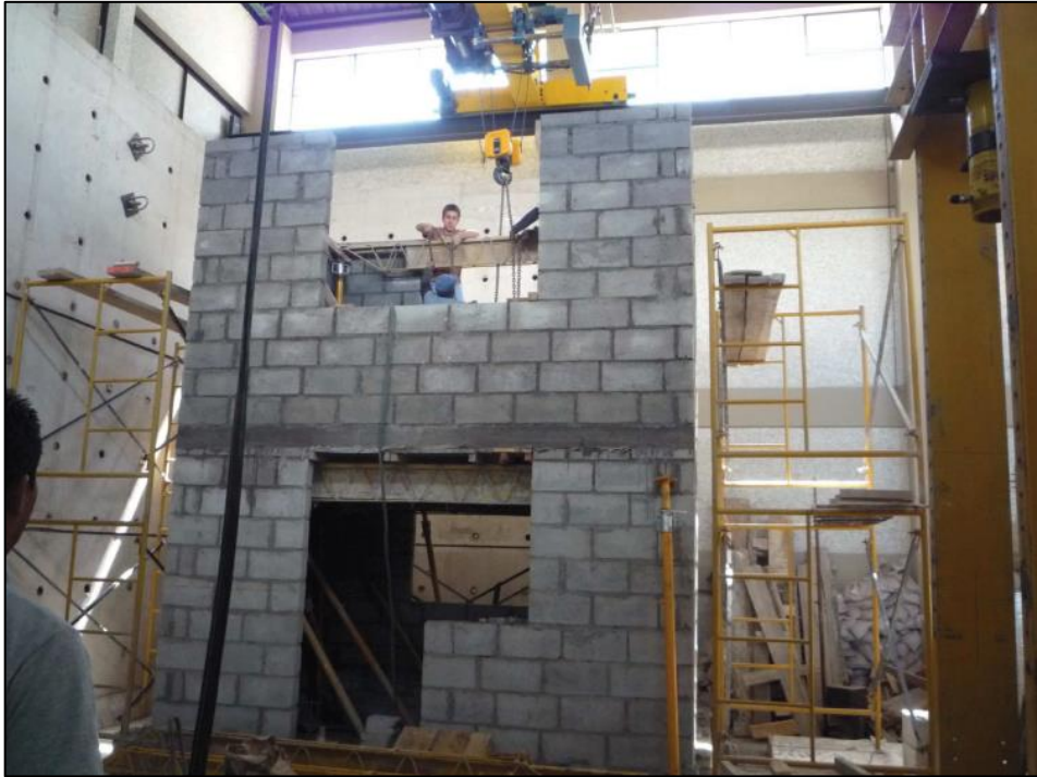
Figura 15. Mampostería terminada del segundo nivel.
