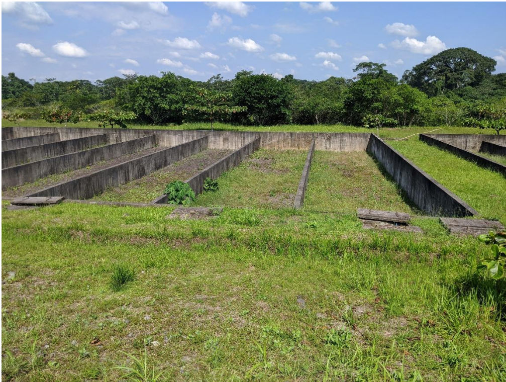
Figura 7 Lechos de secado
