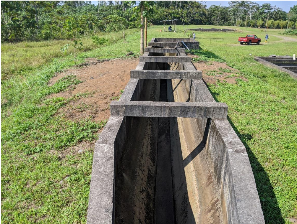
Figura 9 Desarenador
