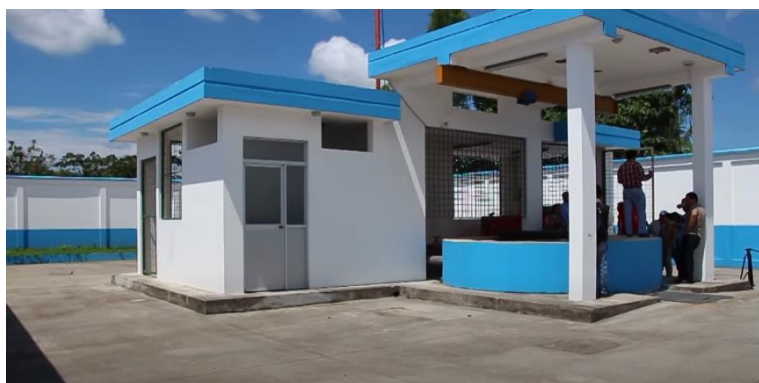
Figura 4 Estación de bombeo de agua residual
