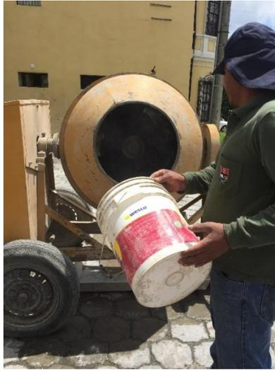
*Figura 4.26. Colocación de materiales en la mezcladora.*
