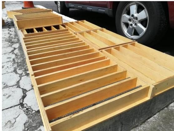
Figura 4.28 Engrasada de encofrado de vigas.
