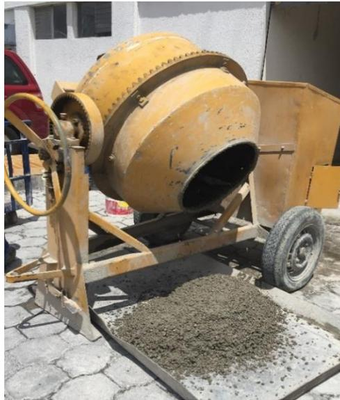
*Figura 4.27. Descarga de concreto en la bandeja.*
