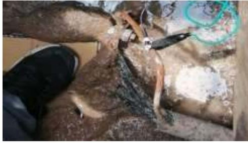
Figura 3-20 Cortocircuito de los cables tierra y neutro.(Fuente Propia)
