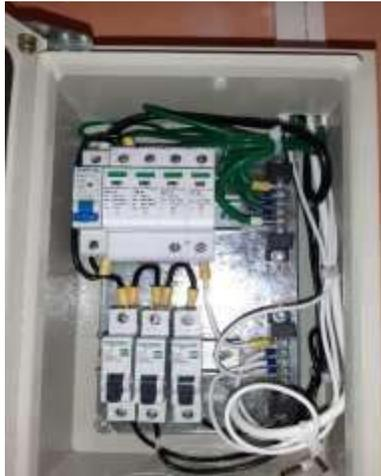
**Figura 3-10** Tablero de protecciones secundario. (Fuente Propia)
