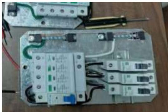
**Figura 3-9** Placa del tablero de protecciones secundario. (Fuente Propia)
