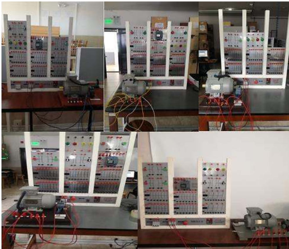
Figura 3.19 Conexión de motores en las mesas de trabajo del laboratorio de Control Industrial.
