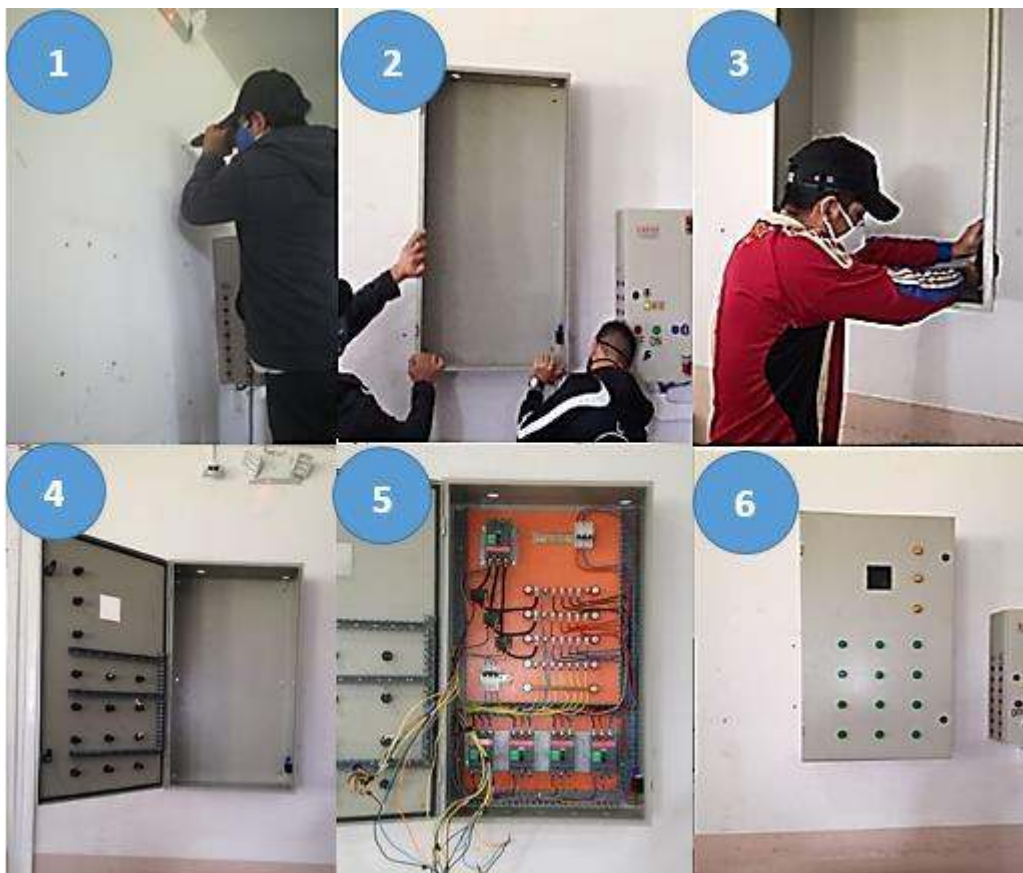
Figura 3.15 Montaje del tablero.
