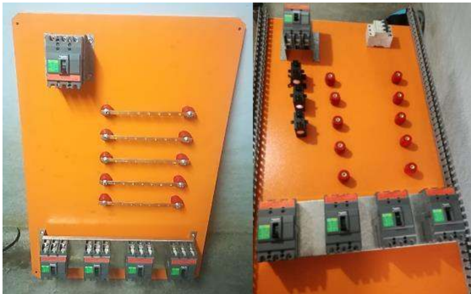
Figura 3.12 Instalación de disyuntores y barras de cobre.
