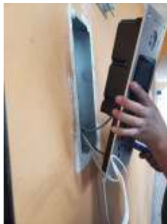
Figura 3.37 Colocación de la estación de puerta
