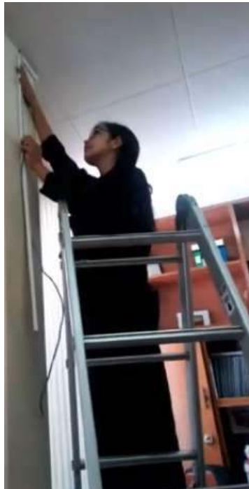
Figura 3.12 Colocación de canaletas
