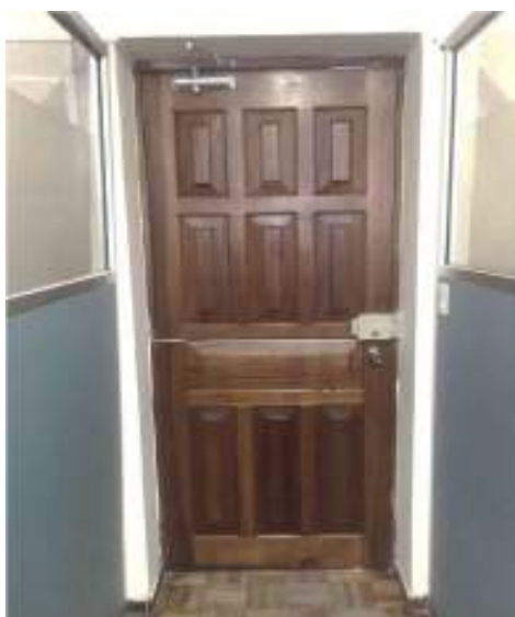
Figura 3.15 Instalación de brazo hidráulico y chapa eléctrica
