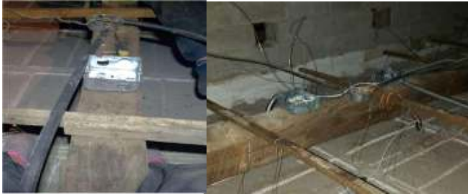
Figura 3.9 Colocación de cajetines de paso, conexión de mangueras metálicas BX
