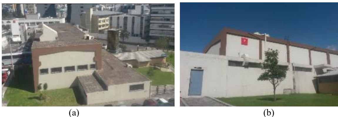
Figura 3.1. Edificio del Centro de Irradiación: a) Vista aérea del edificio del CIR, b) Entrada posterior al edificio del CIR (Villacis, 2019)
