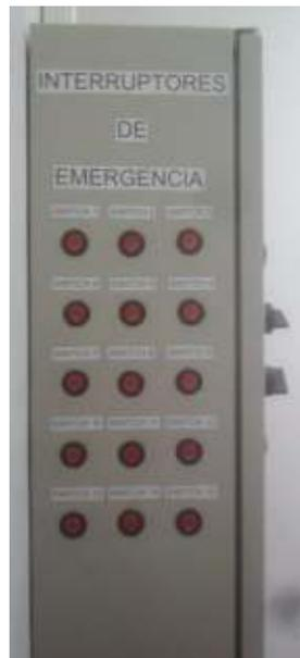
**Figura 3.18** Interruptores de emergencia montados y asegurados en el gabinete.
