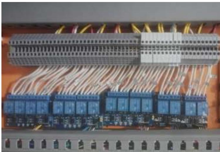
**Figura 3.31** Cableado de los módulos relés.
