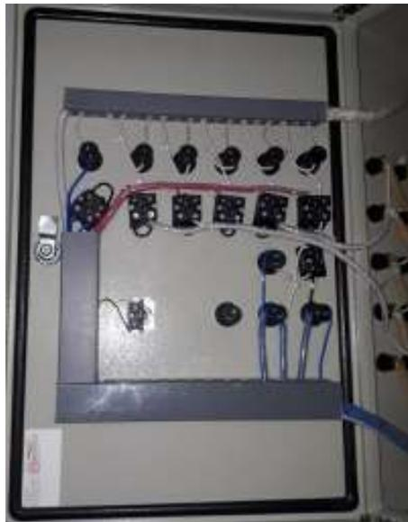
**Figura 3.29** Cableado de los elementos de maniobra.
