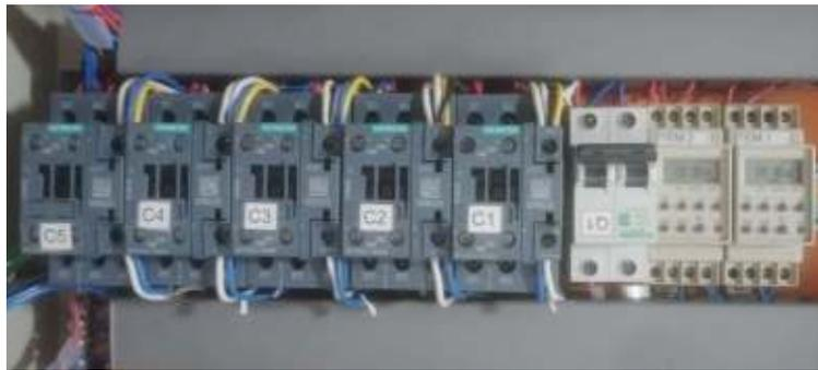
**Figura 3.30** Cableado de los contactores.
