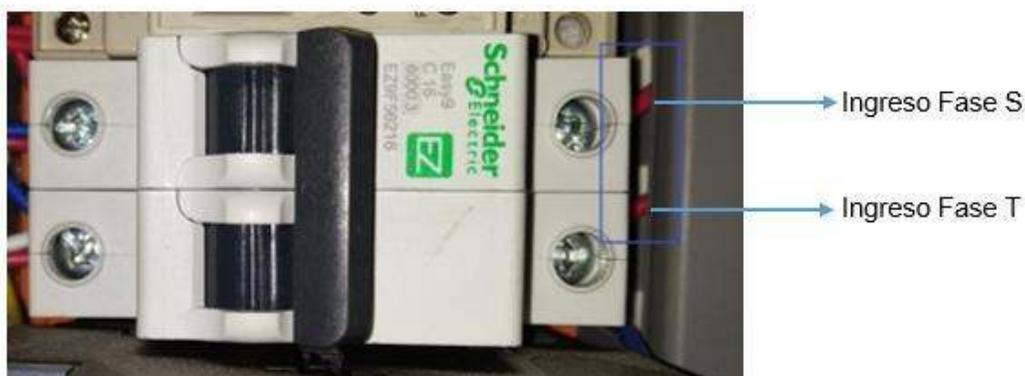
**Figura 3.32** Protección principal del tablero.
