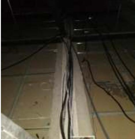
**Figura 3.7** Cableado de la acometida eléctrica por dentro de los techos de la ESFOT.
