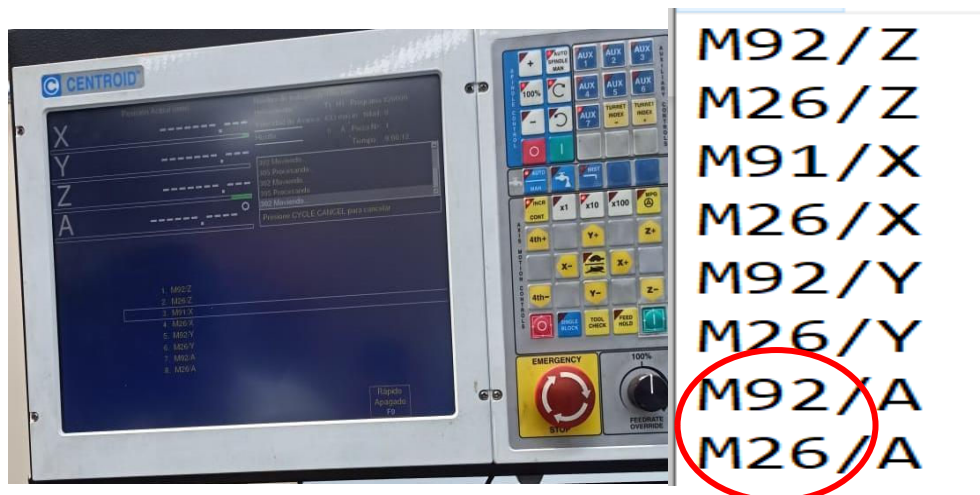
Figura 3.79. Activación de cuarto eje en el controlador mediante códigos M [Fuente: Propia].
