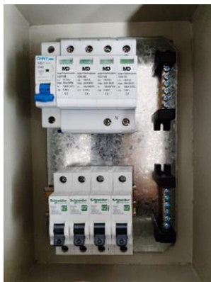
Figura 3.11 Diseño del tablero del sistema de protección.
