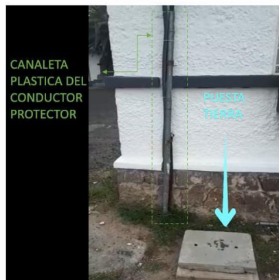
Figura 3.18 Suelda exotérmica de puesta tierra de la zona 3.
