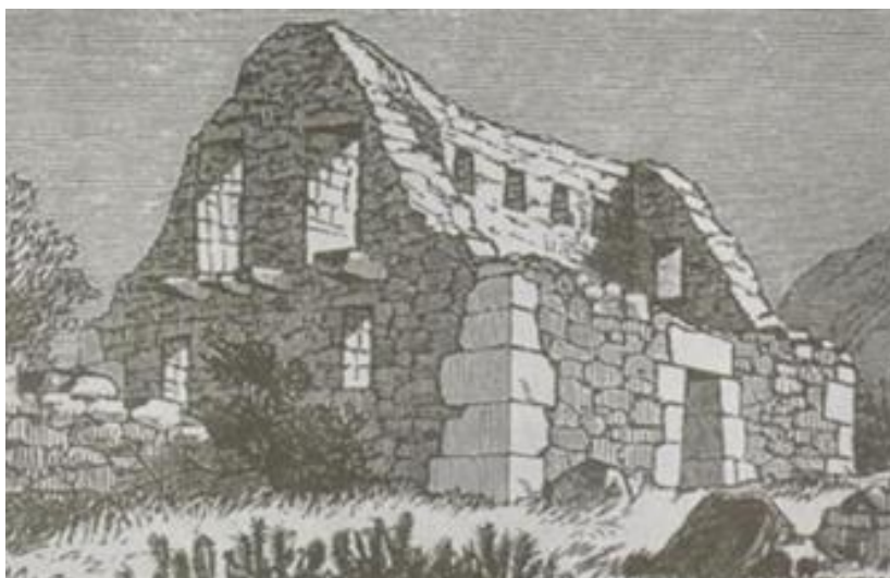
Imagen 4. Edificaciones en las laderas. Muros de piedra con mortero de barro Fuente: (Gallegos & Casabonne, 2005)
