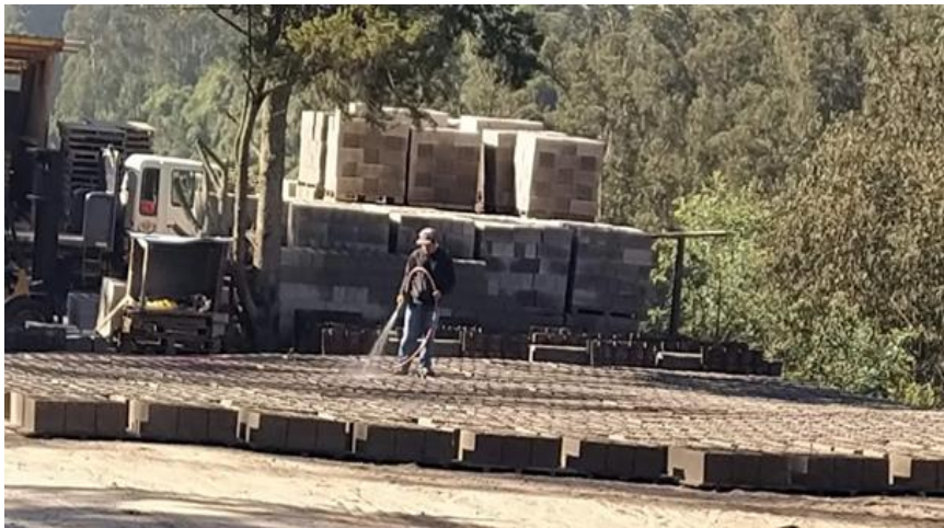
Fotografía 11. Proceso de secado y curado de bloques huecos de hormigón ELABORADO POR: Aigaje y Chalco (2021)
