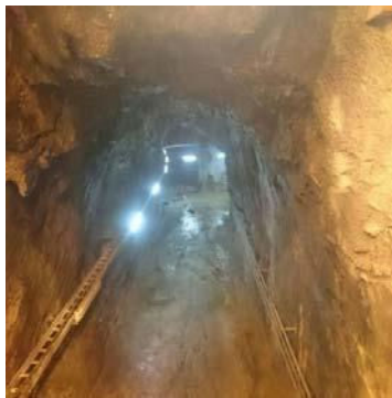
a) Túnel de carga en mantenimiento
