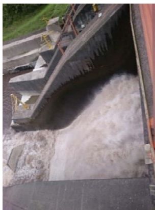
Compuertas abiertas para la descarga del agua
