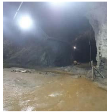
b) Interior del túnel de carga
