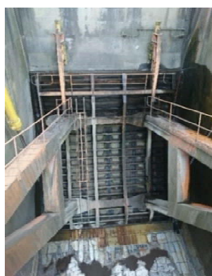
b) Vista frontal de la compuerta en la represa
