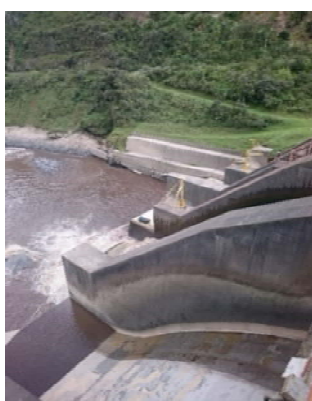
a) Represa Agoyan compuerta cerrada
