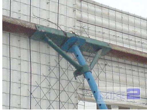
2.- Apuntalamiento de paneles
