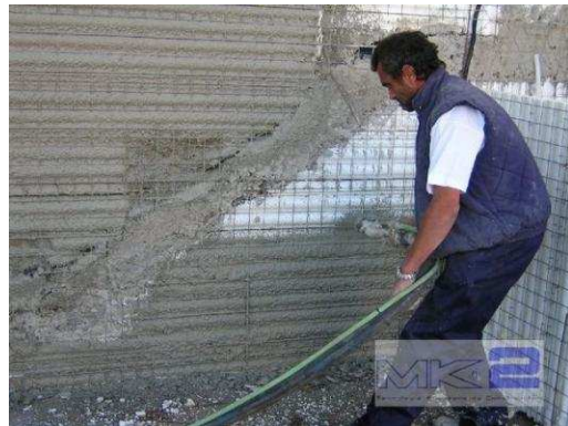
4.- Lanzamiento de micro-hormigón
