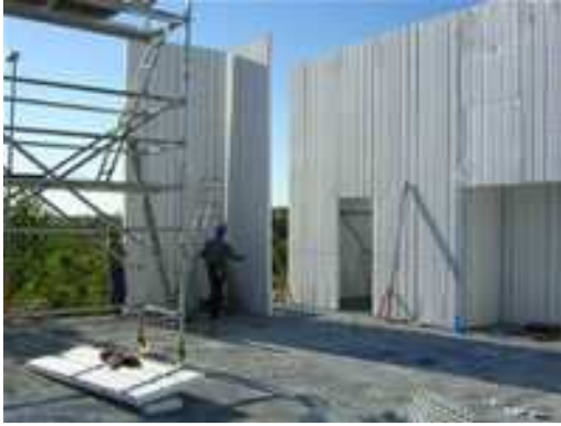
1.- Levantamiento de paneles
