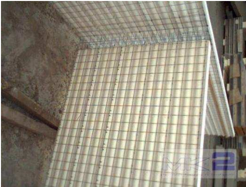
3.- Montaje de paneles losa
