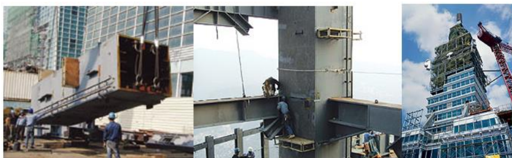
Figura 26. Edificio Taipei 101 FUENTE: (Cereno de Freitas, 2005)
