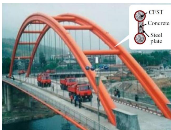
Figura 23. Puente Wangchang East River FUENTE: (Han et al., 2014)
