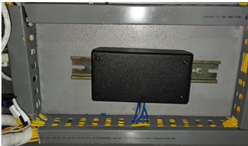
Figura 3.23 Montaje del circuito de acondicionamiento.
