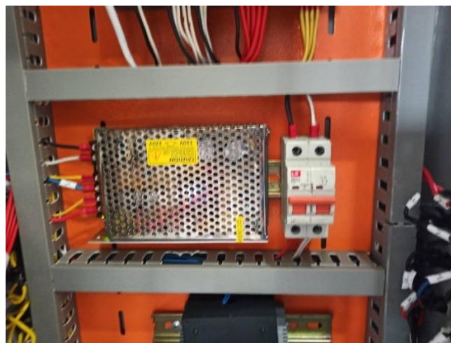
Figura 3.22 Montaje de fuente de 24 (V DC ) e interruptor termomagnético.
