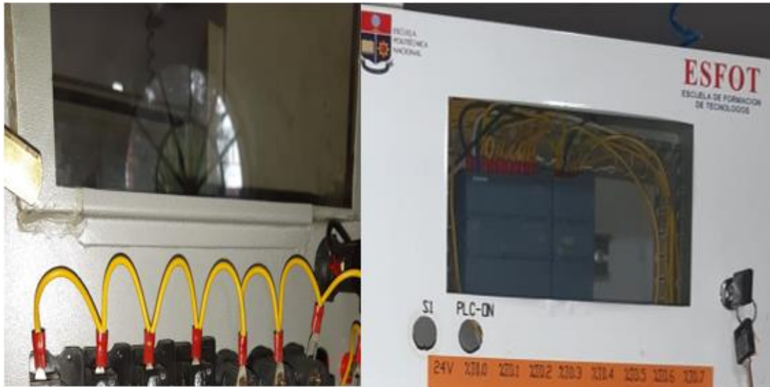
Figura 3.4 Cubierta antigua del módulo.
