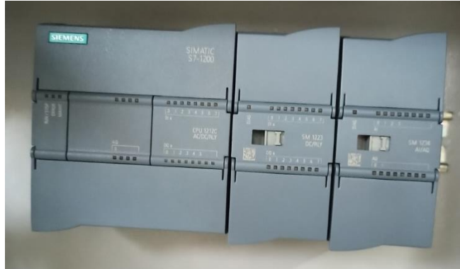
Figura 3.21 Montaje del PLC y los módulos de expansión.
