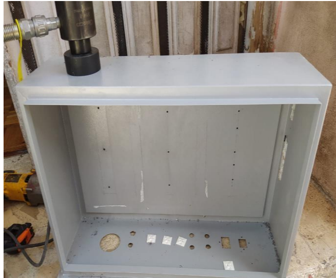
Figura 3.9 Perforación de agujeros para los ventiladores.
