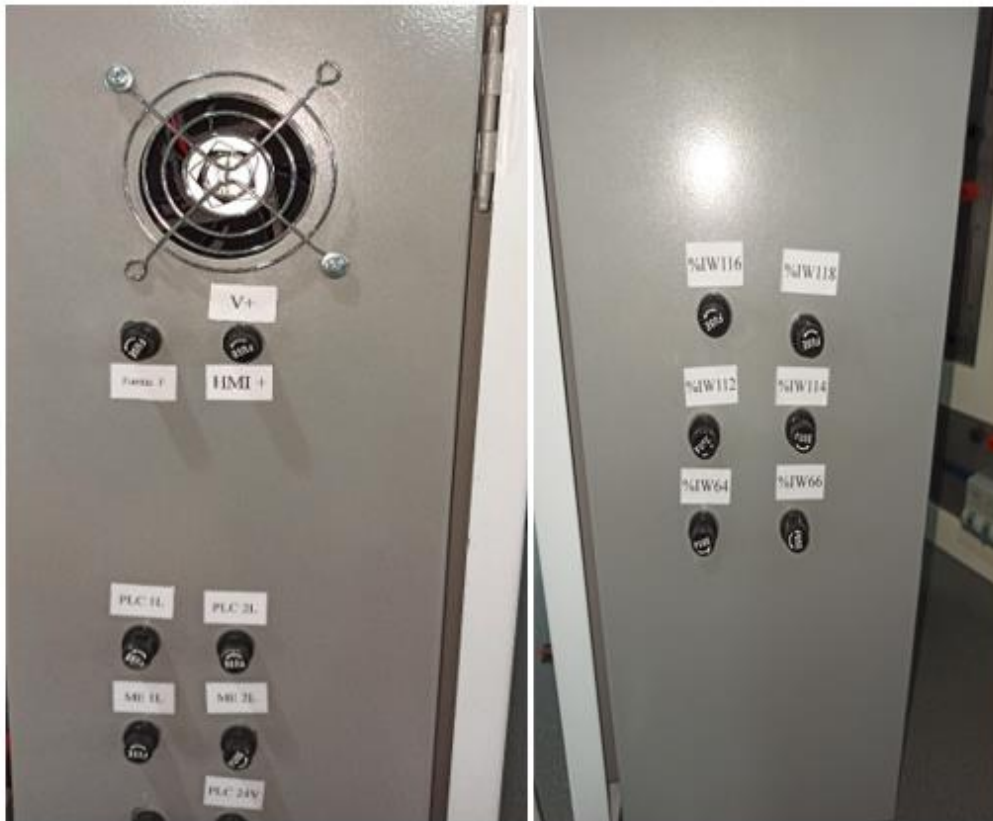
Figura 3.43 Etiquetado del exterior de los módulos.
