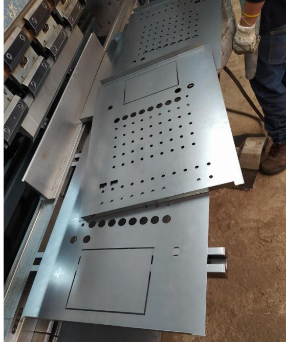
Figura 3.5 Proceso de fabricación de las nuevas cubiertas.
