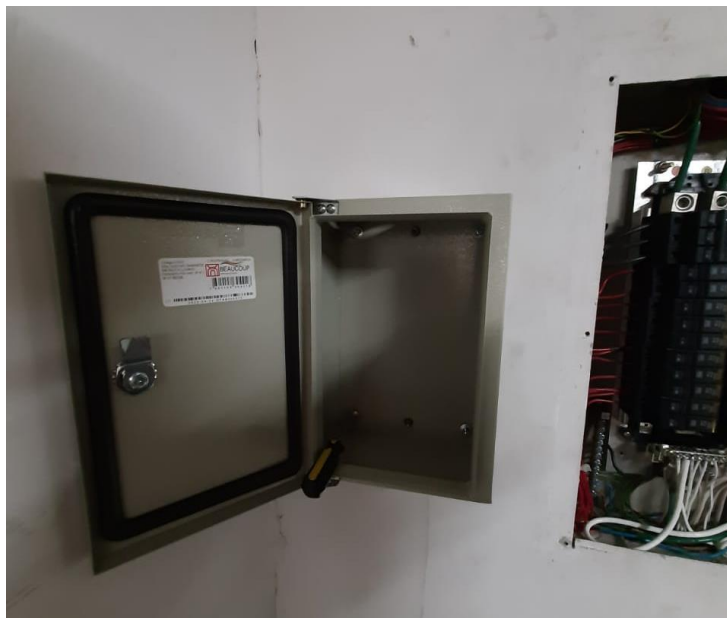
Figura 3.15 Fijación del tablero a la pared
