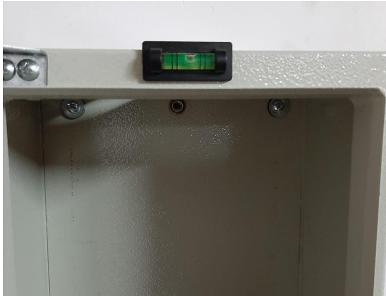
Figura 3.14 Comprobación de nivel del tablero.
