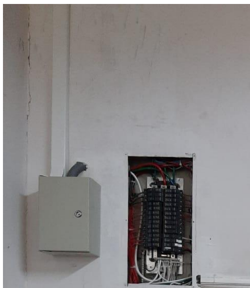
Figura 3.23 Instalación de canaletas TP-LTI
