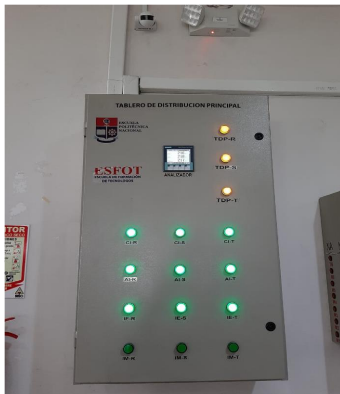
Figura 3.24 Instalación de canaletas TDP
