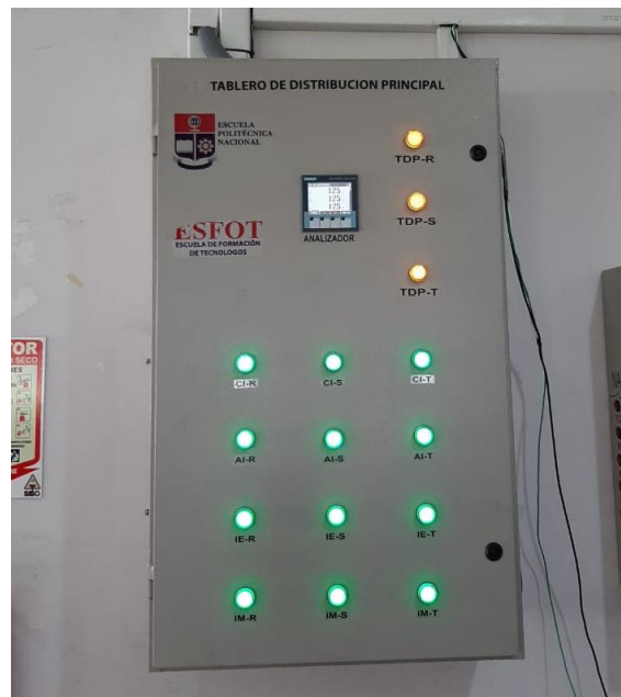
Figura 3.2 Ubicación de llegada de la acometida.
