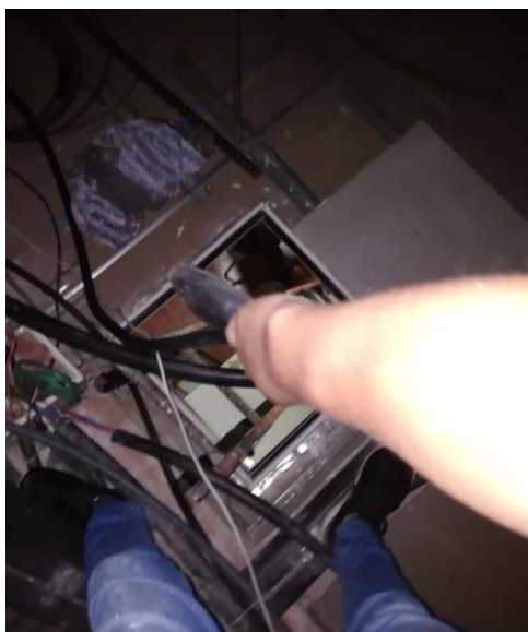
Figura 3.19 Instalación del cable
