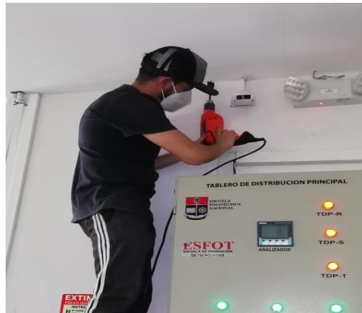
Figura 3.20 Perforaciones para pasar el cable.
