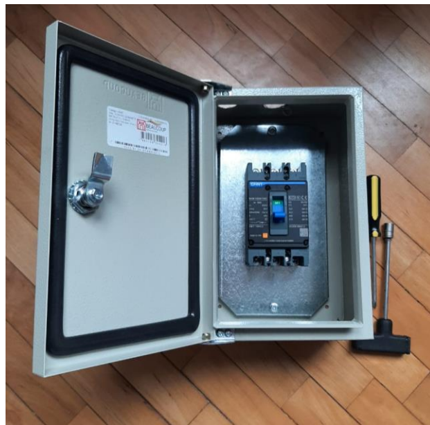
Figura 3.12 Montaje de elementos en el tablero.
