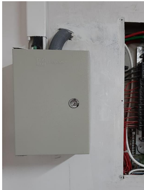
Figura 3.22 Perforación y reparación de pared.
