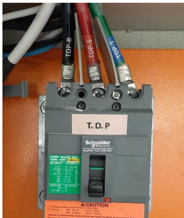
Figura 3.31 Instalación de cables del termomagnético TDP
