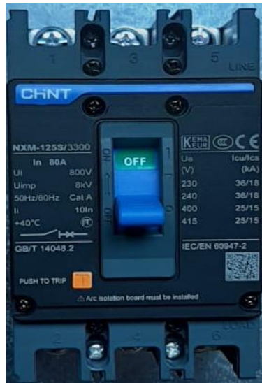
Figura 3.5 Termomagnético de caja moldeada 80 (A)
