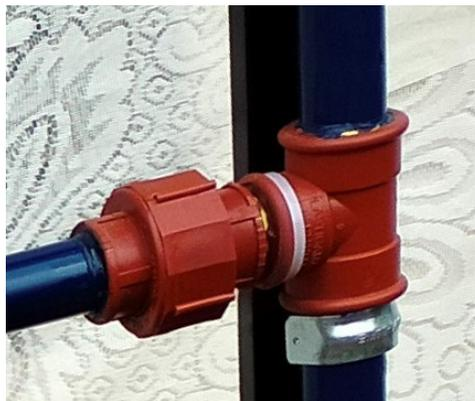
**Figura 3.6** Unión de tuberías y accesorios PVC.
