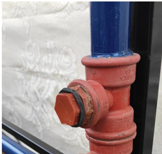
**Figura 3.17** Corrección de fugas en acoples.
