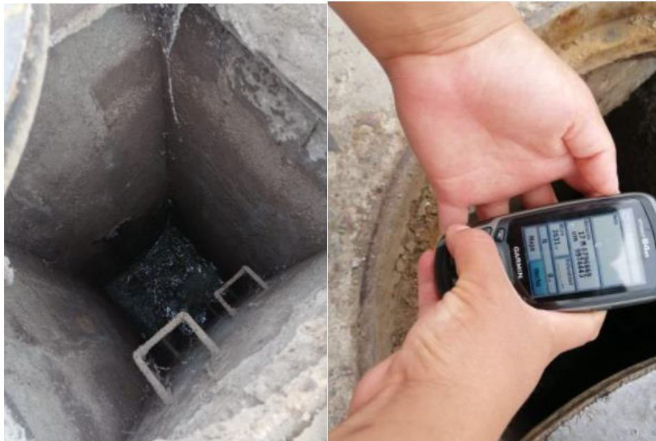
Figura 12. Catastro del pozo 1
