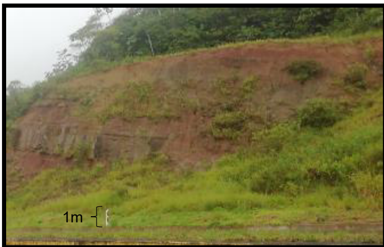
Figura 3.20 “Redbeds” en la vía Macas-Guamote hacia la intersección de la Gral. Proaño.
