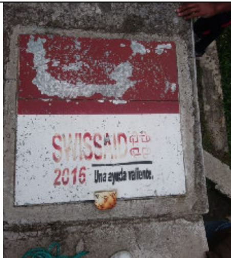
FOTOGRAFÍA 3: Reservorio de agua
