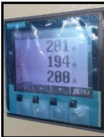
**Figura 81.** Corriente de alimentación del motor
