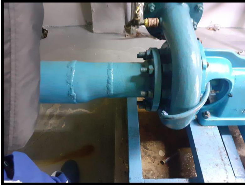
**Figura 74** Tubería de succión con reducción al ingreso de la bomba
