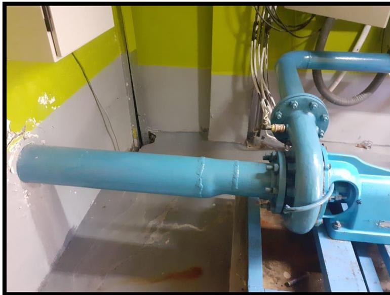
**Figura 73.** Tubería de succión desde el tanque 1 al sistema de bombeo
