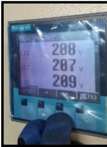
**Figura 80.** Voltaje de alimentación del motor
