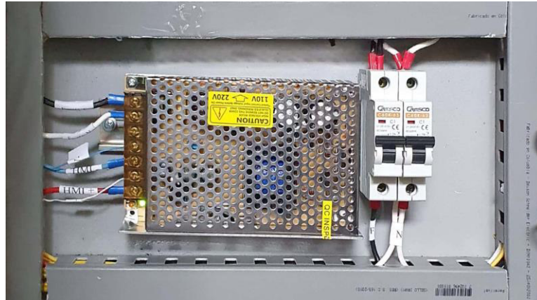
Figura 3.16 Fuente externa instalada en los módulos.
