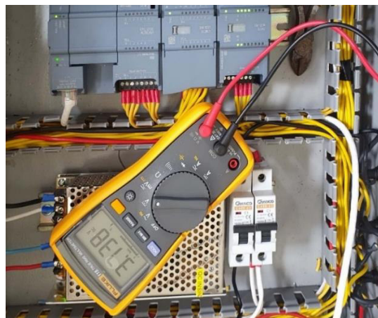
Figura 3.35 Verificación de voltaje.
