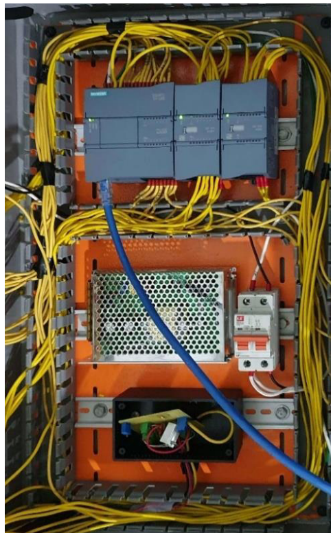
Figura 3.31 Conexiones terminadas de los módulos.
