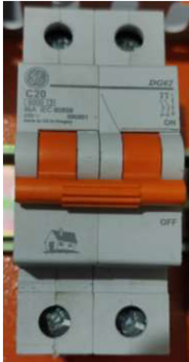
Figura 3.7 Interruptor automático para el ventilador extractor.
