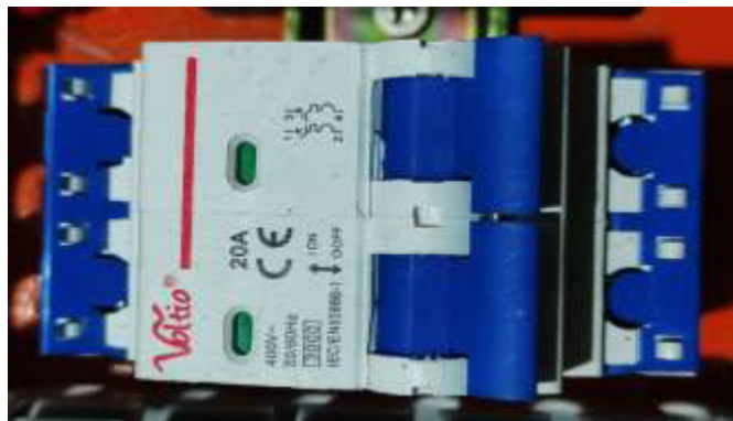
Figura 3.6 Interruptor automático para módulo de trabajo 20 (A).
