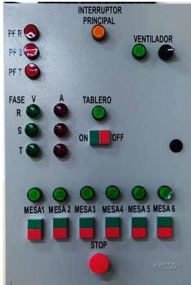
Figura 3.18 Instalación de elementos de mando e indicación (externo).
