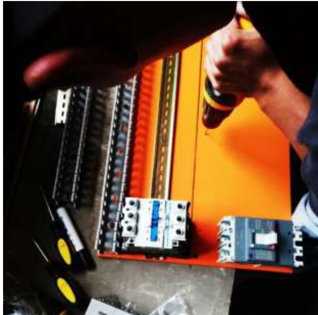
Figura 3.14 Colocación de canaleta y riel.
