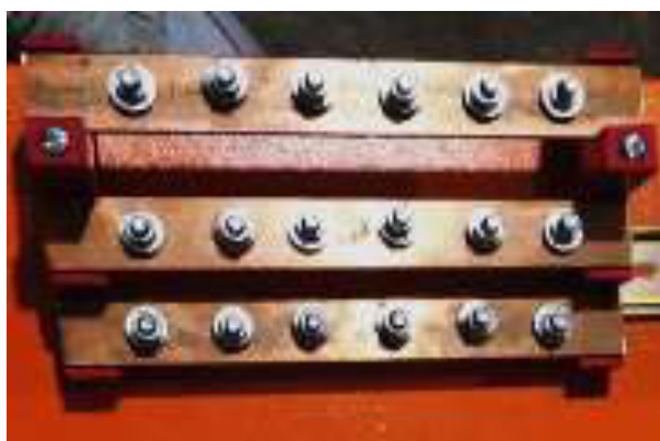
Figura 3.16 Barras de potencial perforadas.
