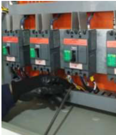
Figura 3.28 Desconexión de las fases de alimentación.
