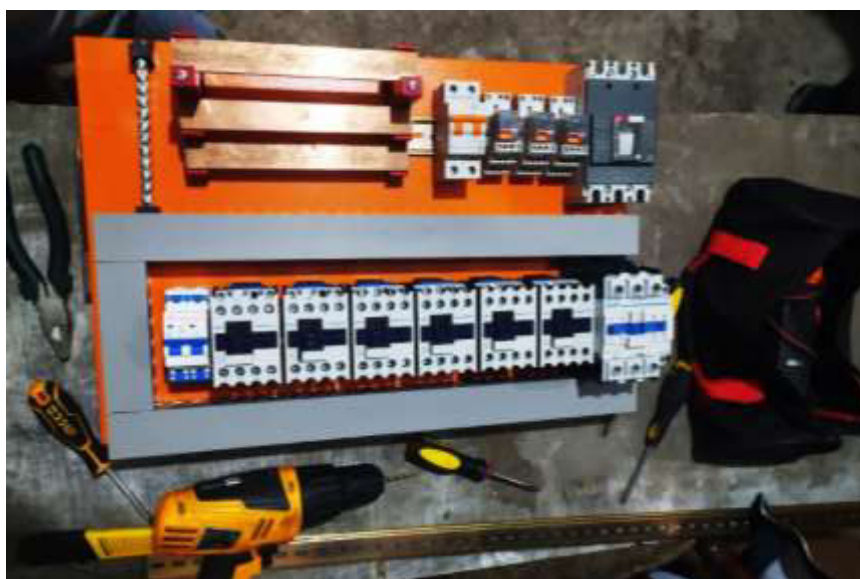
Figura 3.15 Instalación de elementos al interior del gabinete.
