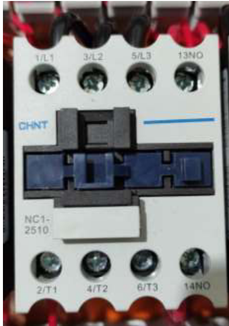
Figura 3.3 Contactor para las mesas de trabajo 25 (A).
