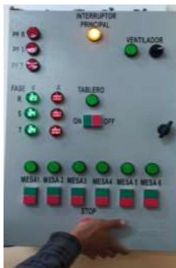
Figura 3.25 Prueba de funcionamiento del paro emergencia.
