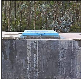
Figura 14. Tanque Desarenador
