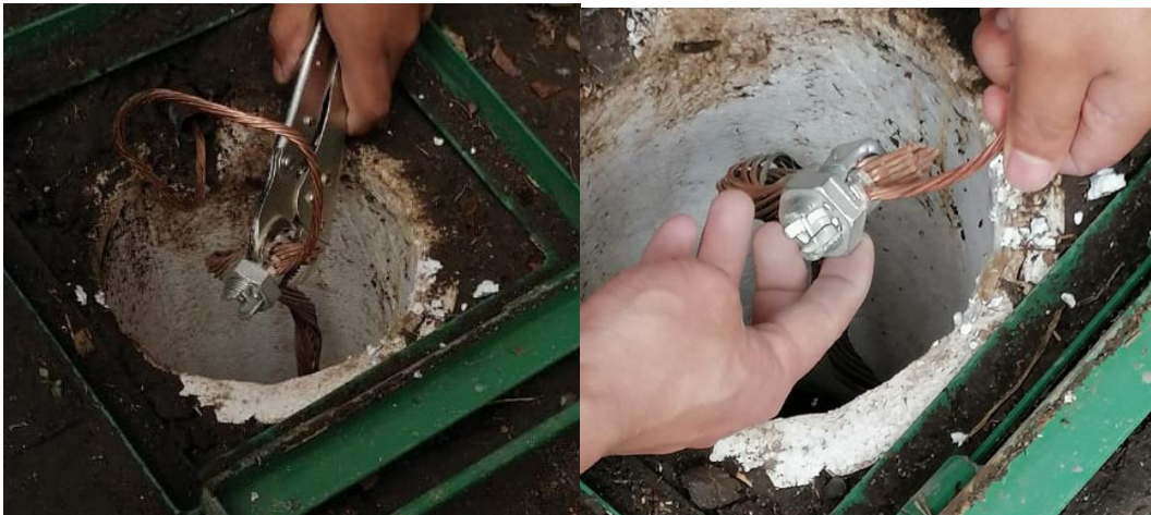
Figura 3.12 Conexión del conductor con el electrodo activo de grafito.
