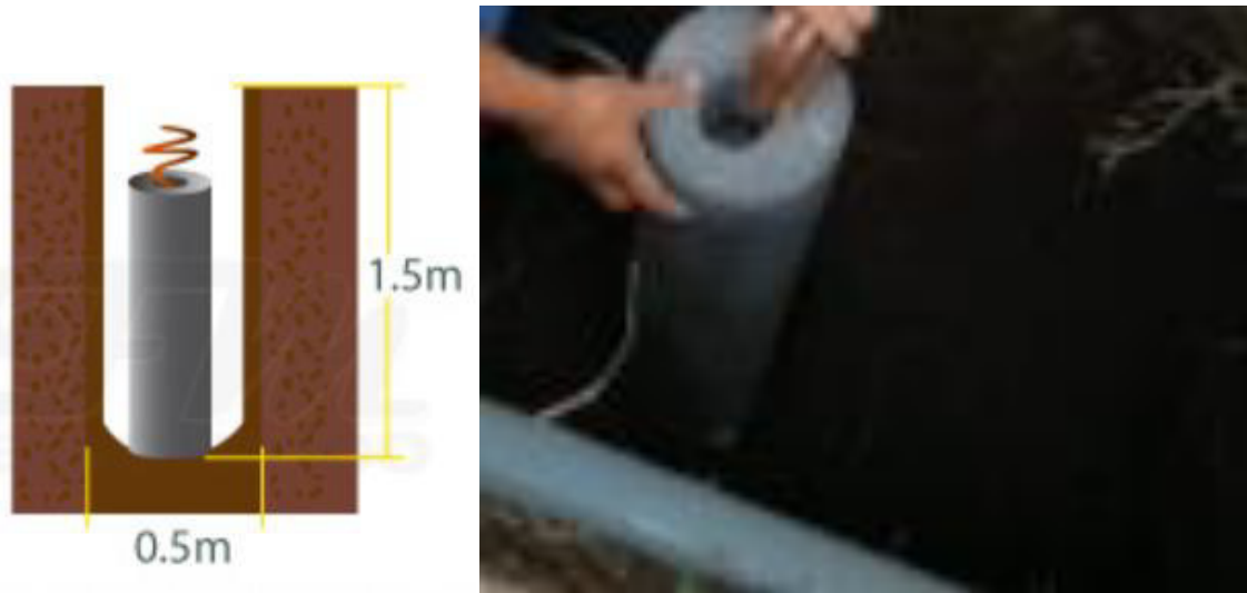
Figura 3.7 Colocación de electrodo químico activo. [5]
