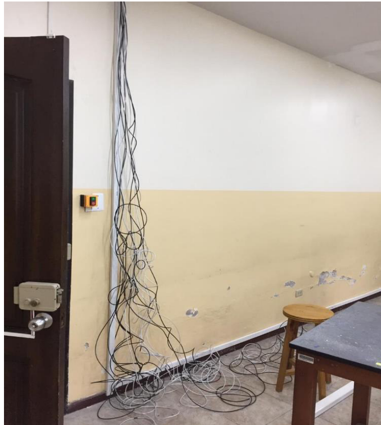
Figura 3.5 Canaletas de PVC blancas
