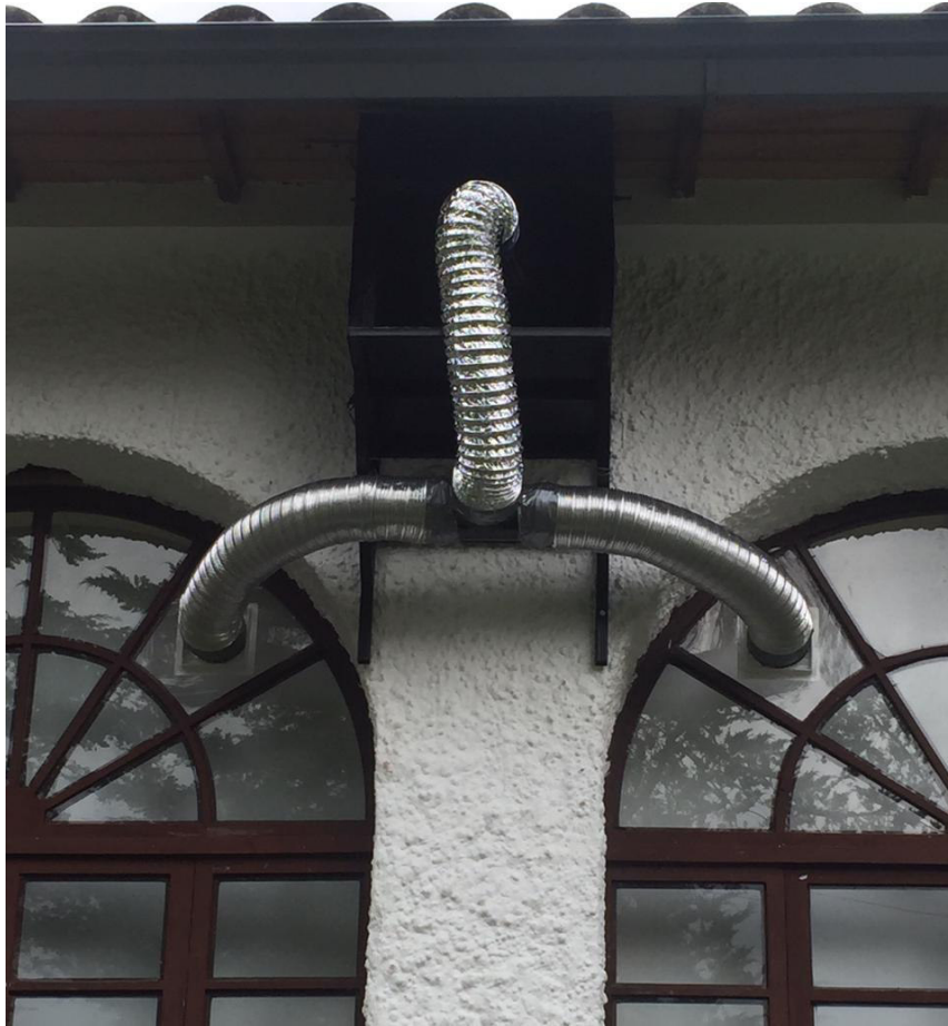
Figura 3.21 Montaje del sistema de extracción de aire
