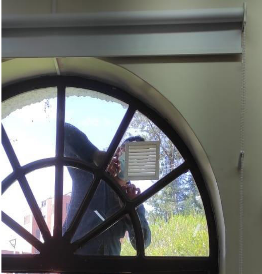
Figura 3.20 Instalación de rejillas
