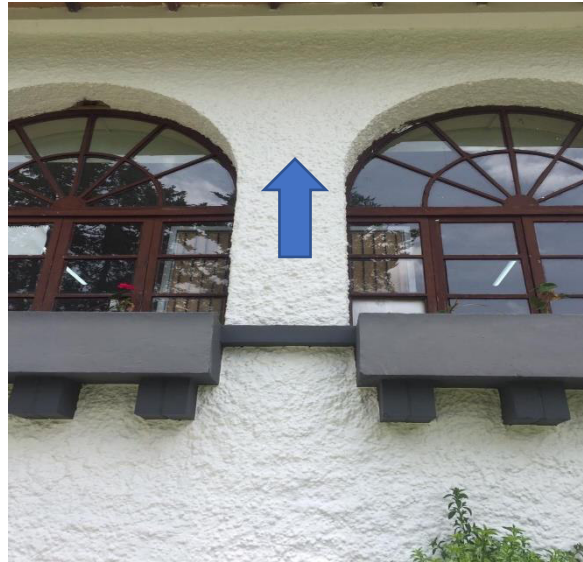
Figura 3.11 Área seleccionada para montaje del sistema de extracción
