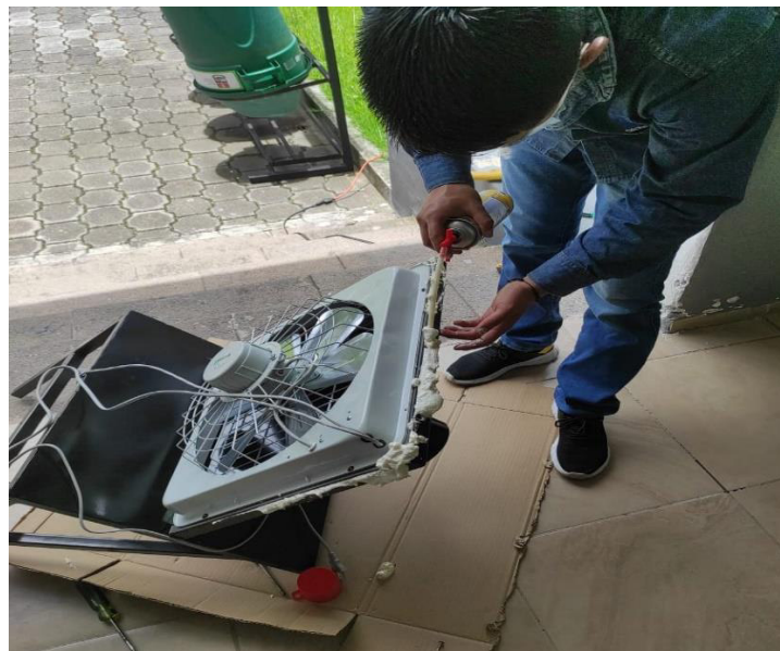
Figura 3.16 Instalación de aislante sicabón
