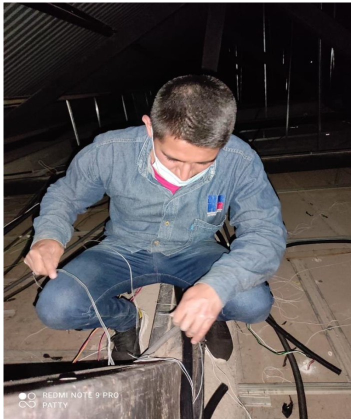
Figura 3.7 Fijación del sistema de cableado a la estructura metálica del edificio
