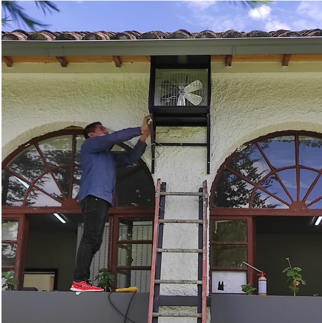
Figura 3.17 Instalación del equipo.
