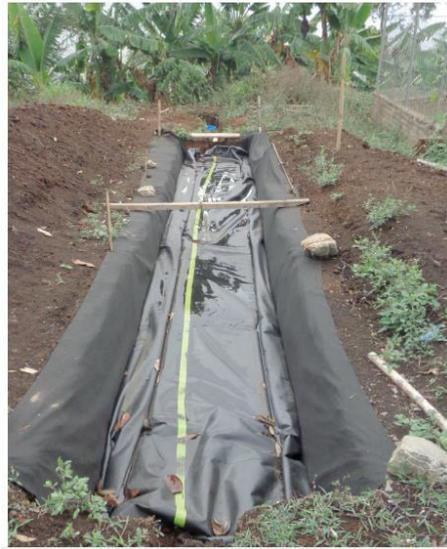
**Figura:** Introducción de la manga dentro de la zanja.
