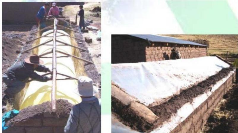
**Figura:** Construcción del invernadero.
