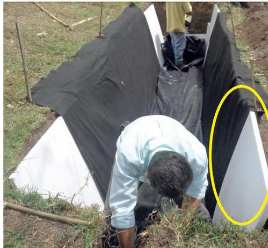
**Figura:** Cobertura del biodigestor
