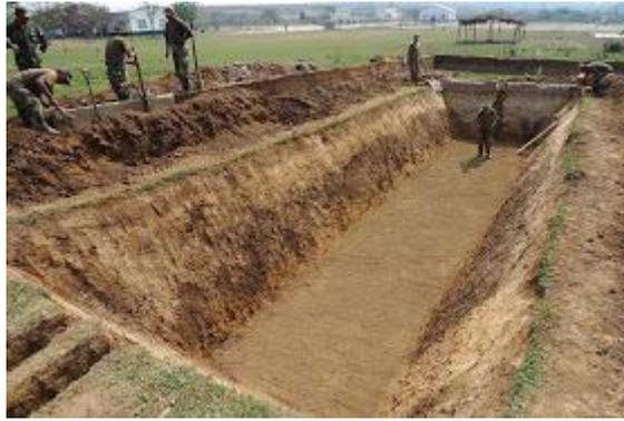
**Figura:** Cavado de zanja y afinación de taludes.
