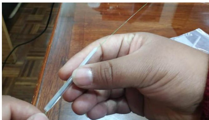
Figura A2.2 Colocación del tubillo de fusión en la fibra óptica
