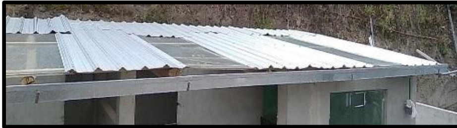
Figura 63. Techo de metal galvanizado.
