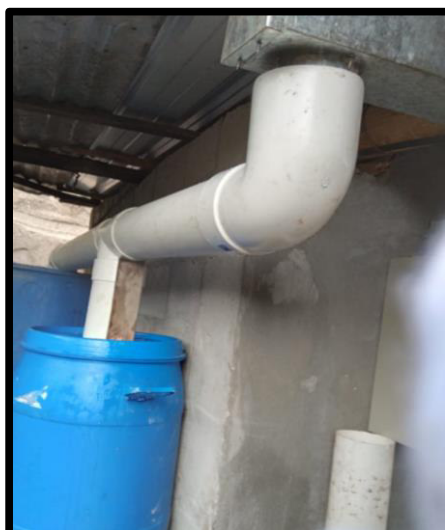
Figura 28. Bajante nueva del sistema.
