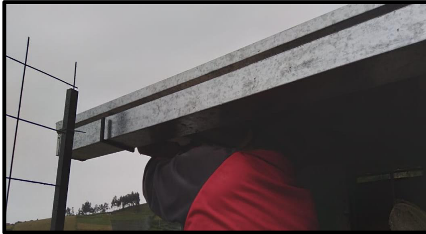
Figura 25. Instalación de canaletas en la zona B.
