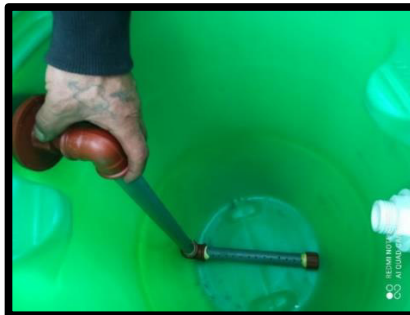
Figura 37. Instalación de la tubería perforada dentro del filtro.
