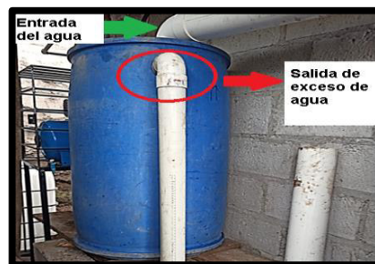
Figura 34. Tanque de recolección de agua lluvia.
