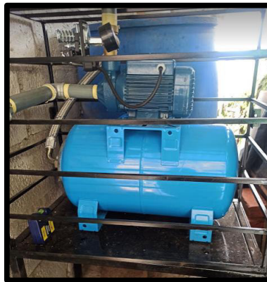
Figura 52. Adaptación de accesorios a la bomba.
