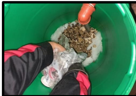
Figura 42. Colocación de grava en el filtro.
