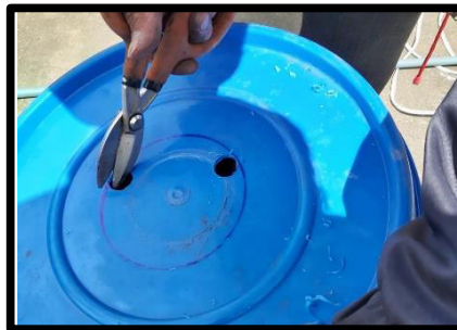
Figura 30. Tanque de regulación de primeras aguas.
