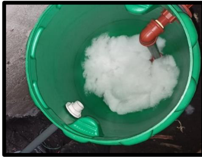
Figura 41. Colocación de algodón dentro de filtro.
