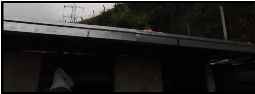
Figura 26. Canaleta instalada en la zona B.
