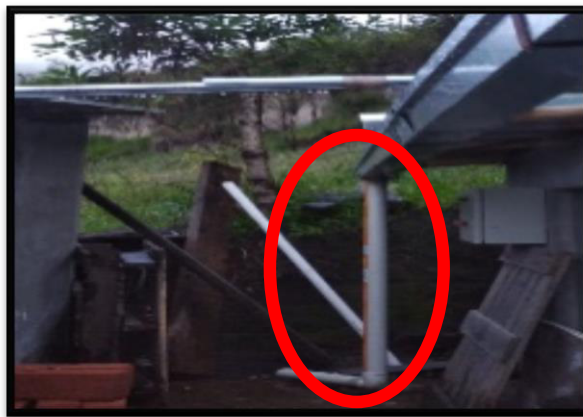
Figura 11. Conducción Pluvial actual.
