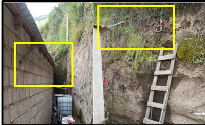
Figura 60. Conexiones del sistema de distribución.
