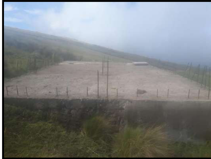
Figura 11. Tanque de almacenamiento
