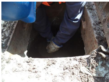
Figura 28. Desobstrucción del sifón con gancho.
