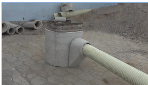
Figura 6. Configuración de sumidero con tirante.
