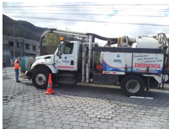
Figura 15. Limpieza con hidrosuccionador.
