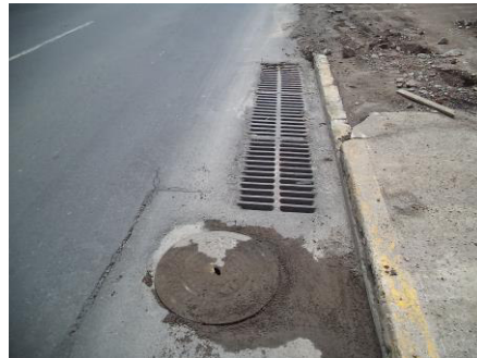
Figura 11. Cajón con rejillas longitudinales.
