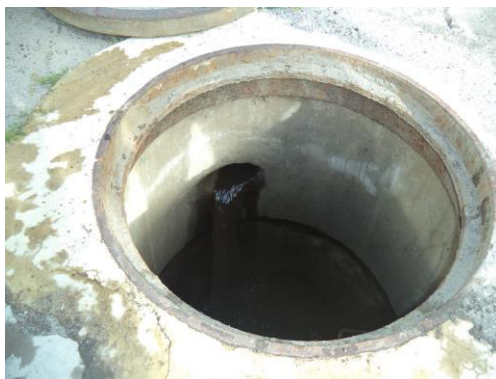
Figura 29. Verificación del flujo de agua.
