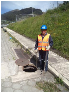
Figura 21. Remoción de accesorios en la limpieza manual.
