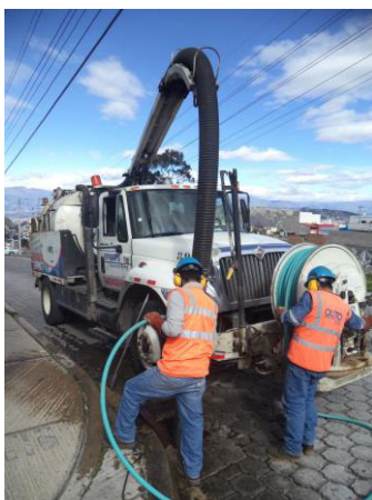
Figura 33. Desalojo de material con hidrosuccionador.
