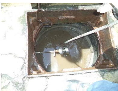
Figura 30. Verificación del flujo con varilla.
