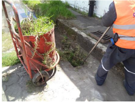
Figura 23. Retiro manual de material.
