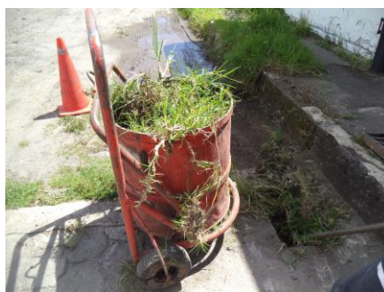
Figura 31. Desalojo manual de material. Fuente: elaboración propia.
