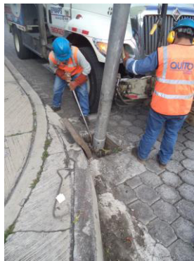
Figura 24. Retiro de material con hidrosuccionador.
