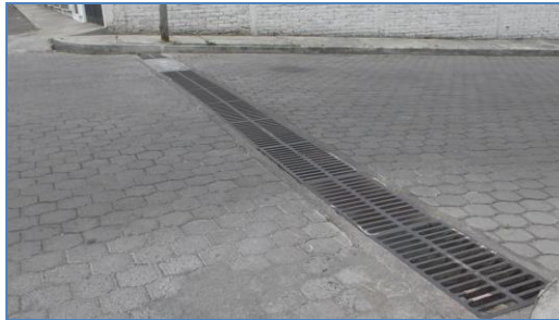
Figura 10. Cajón con rejillas transversales.
