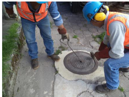
Figura 22. Remoción de accesorios en la limpieza con hidrosuccionador.
