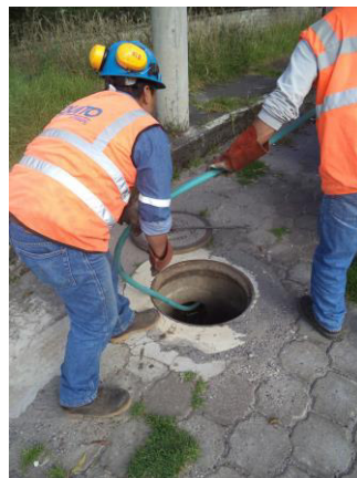
Figura 26. Lavado del tirante de sumidero.
