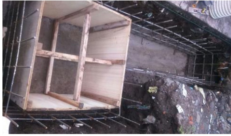
Figura 8. Cajón de hormigón.
