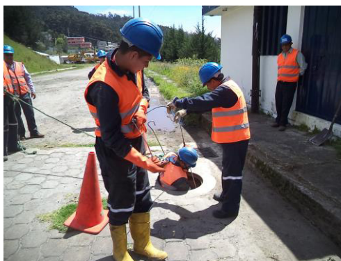
Figura 27. Desobstrucción del tirante con varilla.
