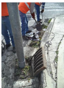
Figura 20. Limpieza zona de influencia con hidrosuccionador.
