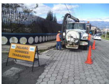
Figura 18. Señalización limpieza con hidrosuccionador.
