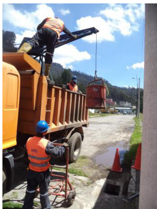
Figura 32. Desalojo mecánico de material.
